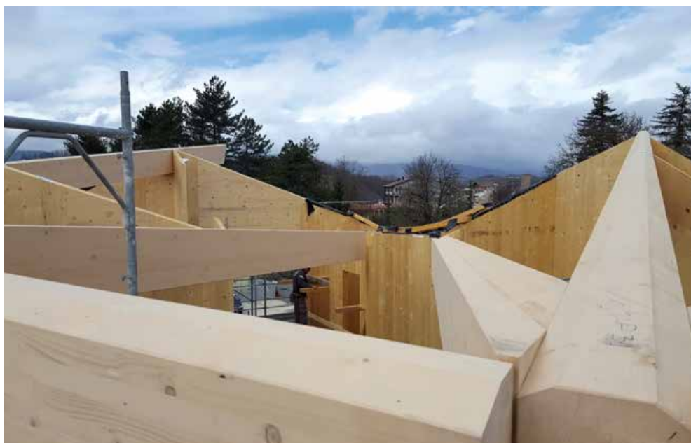
I Lavori della Casa della Montagna. Foto: Fabio Desideri
