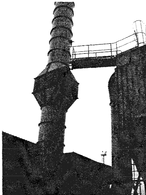
Fig. 3.16.1 Camino dotato di silenziatore
