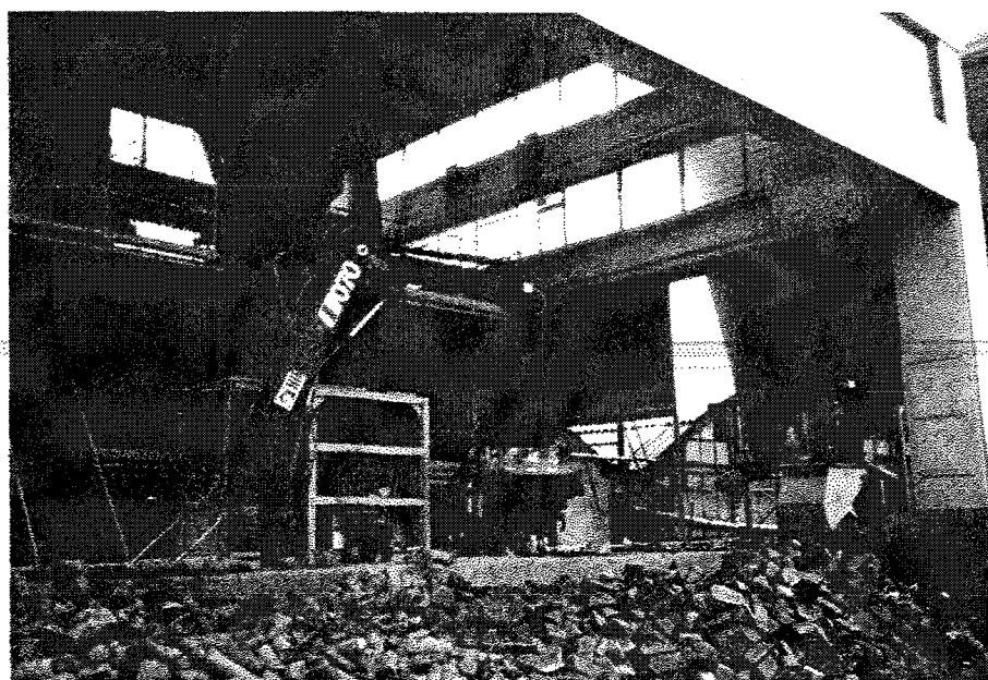
Fig. 3.9.3 Impianto di caricamento dei forni con elettromagnete per la presa dei pani di ghisa dal loro deposito. La cabina dell'operatore alla gru è climatizzata
