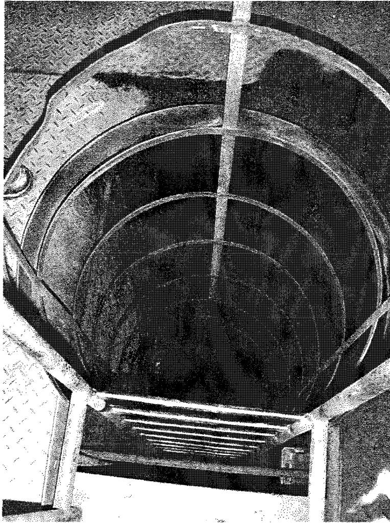
Fig. 3.2.10 Accesso ai cunicoli sotterranei tramite scala verticale fissa dotata di gabbia di protezione, la cui botola è protetta da parapetto e fascia fermapièdi
