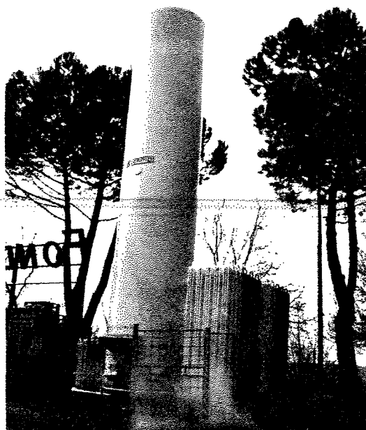
Fig. 3.9.28 Serbatoio di stoccaggio dell'ossigeno liquido per i forni rotativi a metano
