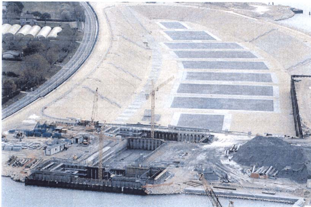
Bocca di Lido - Treporti: il porto rifugio lato mare, il cui bacino messo all'asciutto viene utilizzato come "tura" per la costruzione dei cassoni di alloggiamento delle paratoie e dei cassoni di spalla della barriera di Treporti. In primo piano la realizzazione della conca di navigazione.
