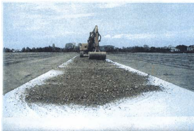
Barena del Passo a Campalto. Copertura dell'area con geocomposto bentonitico sopra il quale vengono stesi materiali diversi (sedimenti di dragaggio, sabbia e terreno vegetale).
