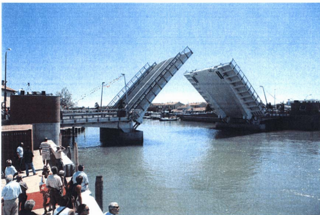
Un'immagine del ponte a lavori ultimati.
