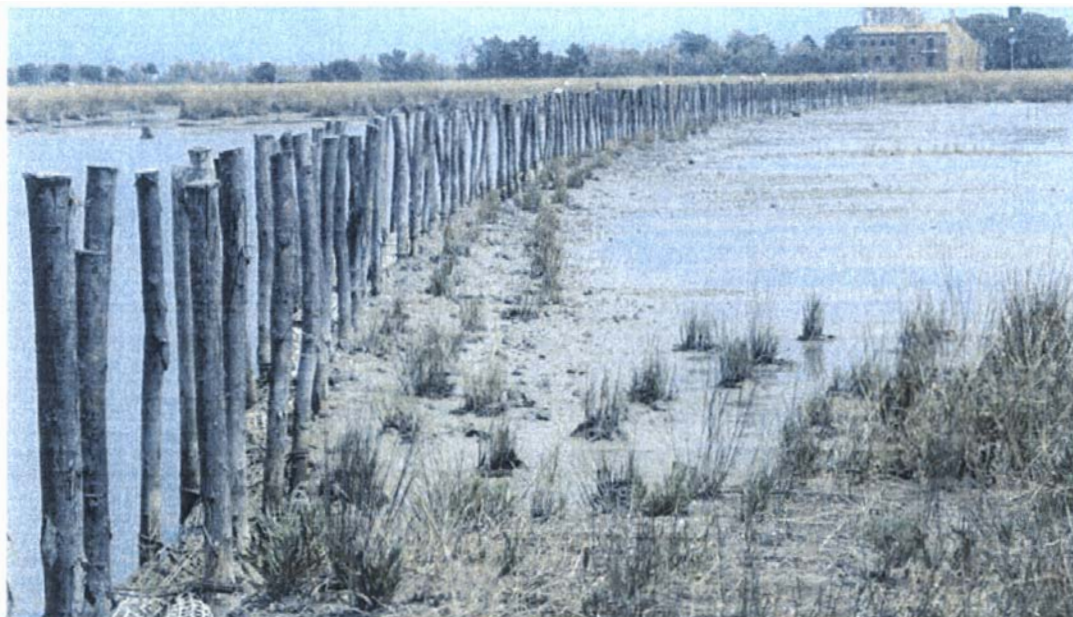
Protezione barene mediante fascinate.
