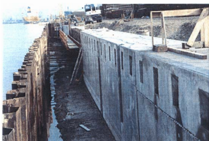
Canale Industriale sud sponda sud, area 43 ettari. Marginamento in fase di lavorazione; Cordolo di marginamento all'interno della tura.
