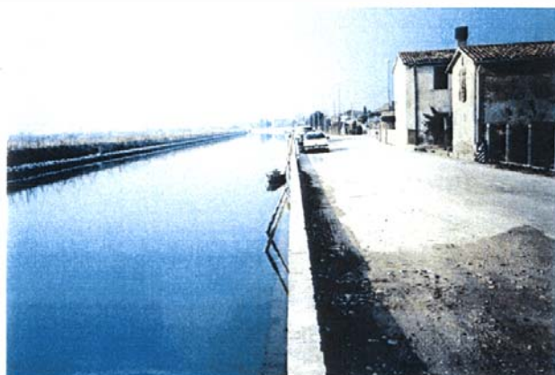
Un tratto di sponda prima dei lavori.
