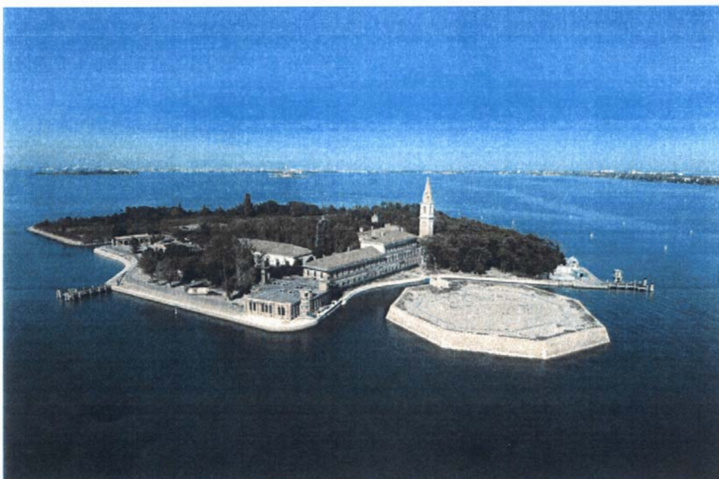
Isola di Poveglia : due immagini dell'isola prima e dopo i lavori.
