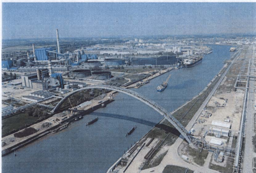
Canale industriale Sud sponda sud. Lavori in fase di esecuzione.
