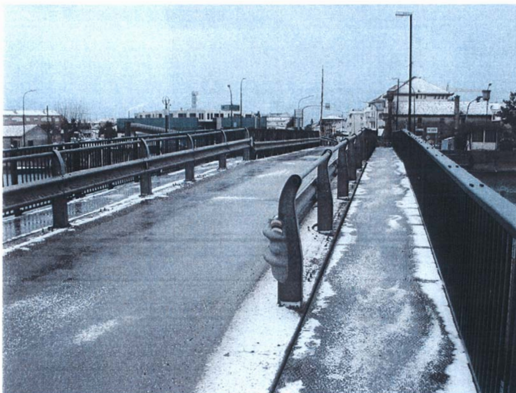
Un'immagine del ponte prima dei lavori.
