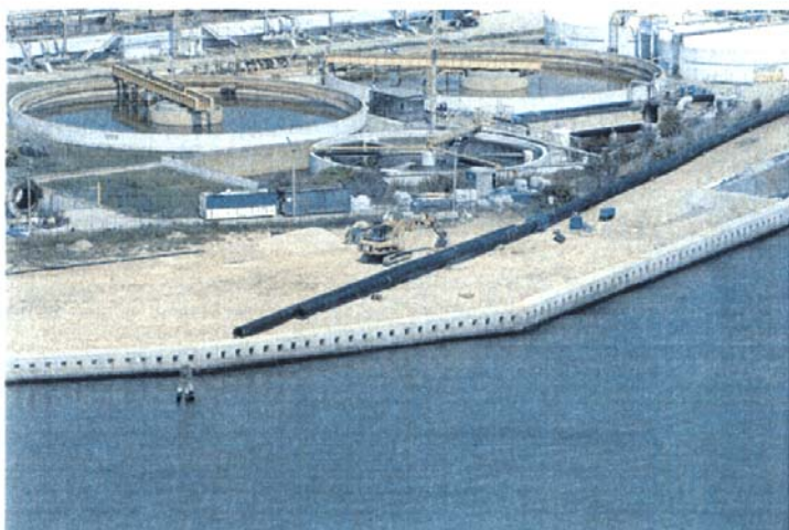
Canale San Leonardo - Marghera tra il bacino di evoluzione 3 e il bacino di evoluzione 4. Marginamento in fase di ultimazione nei pressi del bacino di evoluzione 4.
