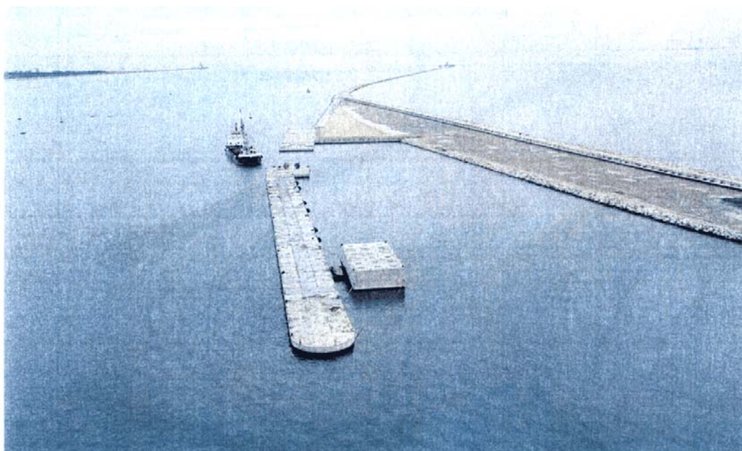
Bocca di Lido - S. Nicolò: I cassoni prefabbricati in calcestruzzo armato che costituiscono la struttura della spalla sud della barriera di S. Nicolò, già posizionati e zavorrati.
