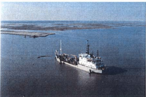
Una fase dei lavori nell'area Torson in laguna sud.
