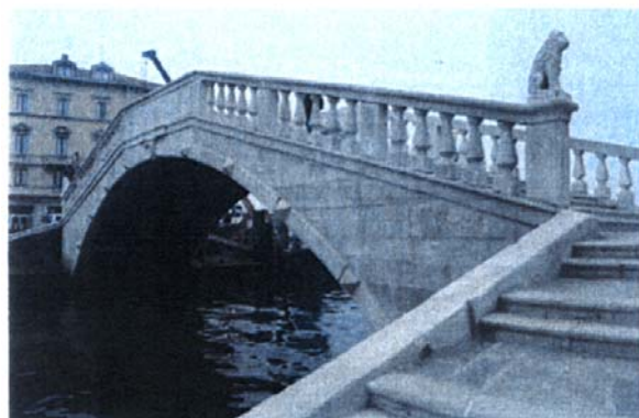
Il ponte Vigo dopo i lavori.
