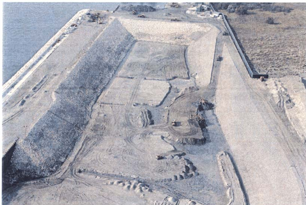
Bocca di Chioggia: particolare del porto rifugio lato mare, messo all'asciutto. Il bacino verrà utilizzato come tura per la prefabbricazione dei cassoni di alloggiamento delle paratoie della barriera di Chioggia.
