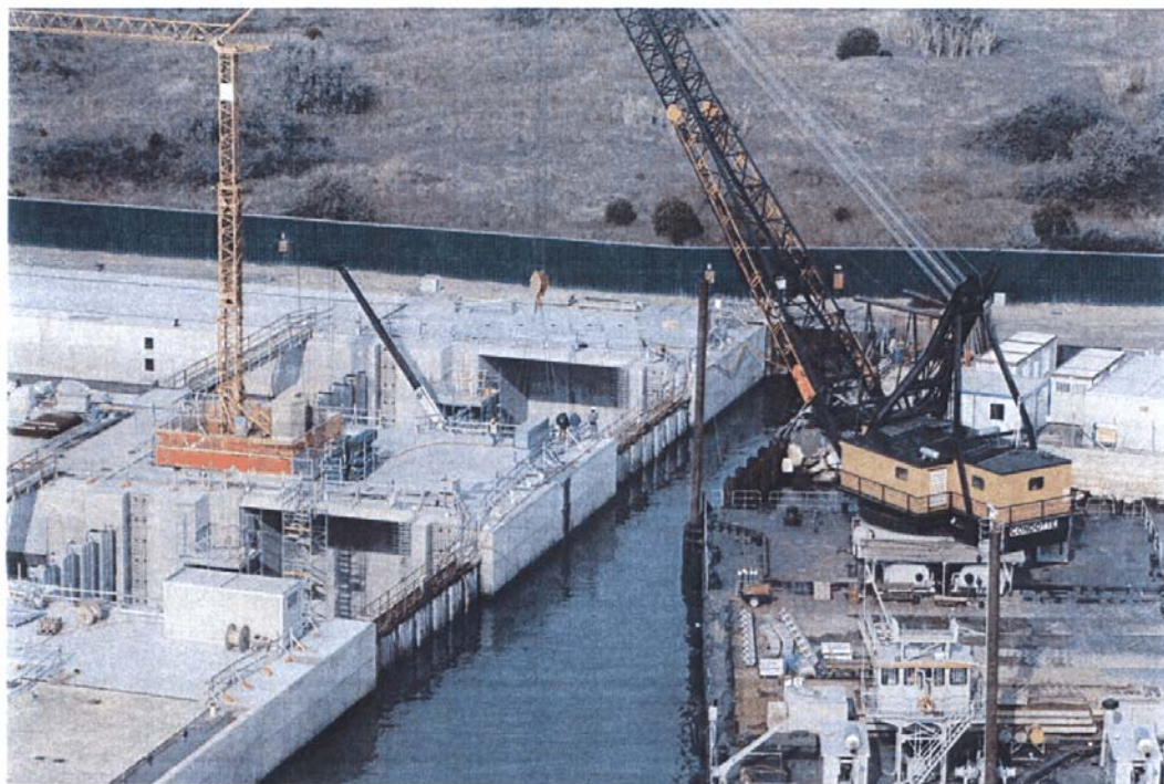
Bocca di Chioggia: particolare delle lavorazioni in corrispondenza della testata lato mare delle conche di navigazione.
