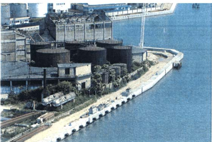
Canale Industriale nord sponda nord. Marginamento ultimato.
