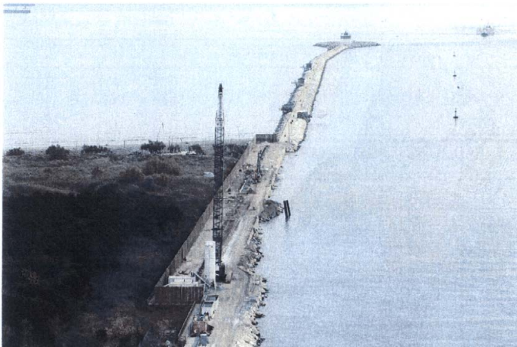
Bocca di Malamocco: particolare del lato Alberoni con le lavorazioni per la spalla nord.
