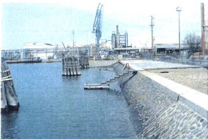
Canale Vittorio Emanuele III sponda nord. Marginamento ultimato in darsena ENI.
