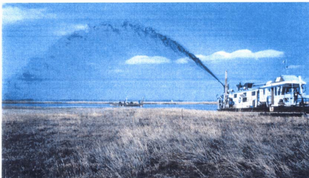
Protezione barene mediante rinascimento.
