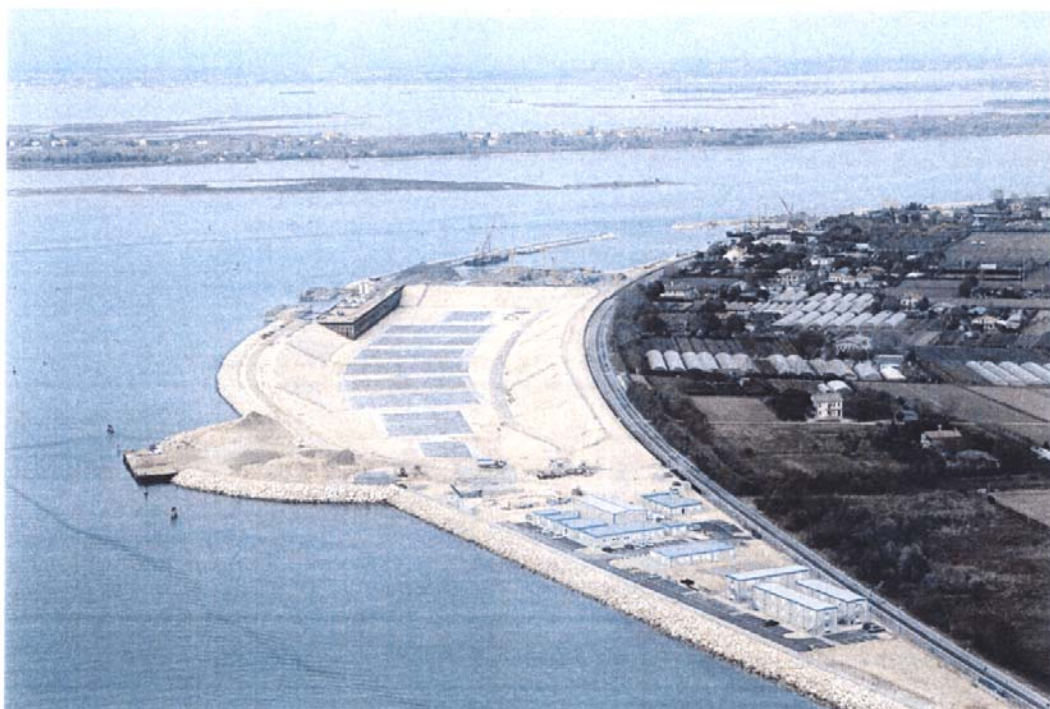
Bocca di Lido - Treporti: il porto rifugio lato mare, il cui bacino messo all'asciutto viene utilizzato come "tura" per la costruzione dei cassoni di alloggiamento delle paratoie e dei cassoni di spalla della barriera di Treporti. Si notano, ultimate, le piastre di appoggio per i casseri dei cassoni.
