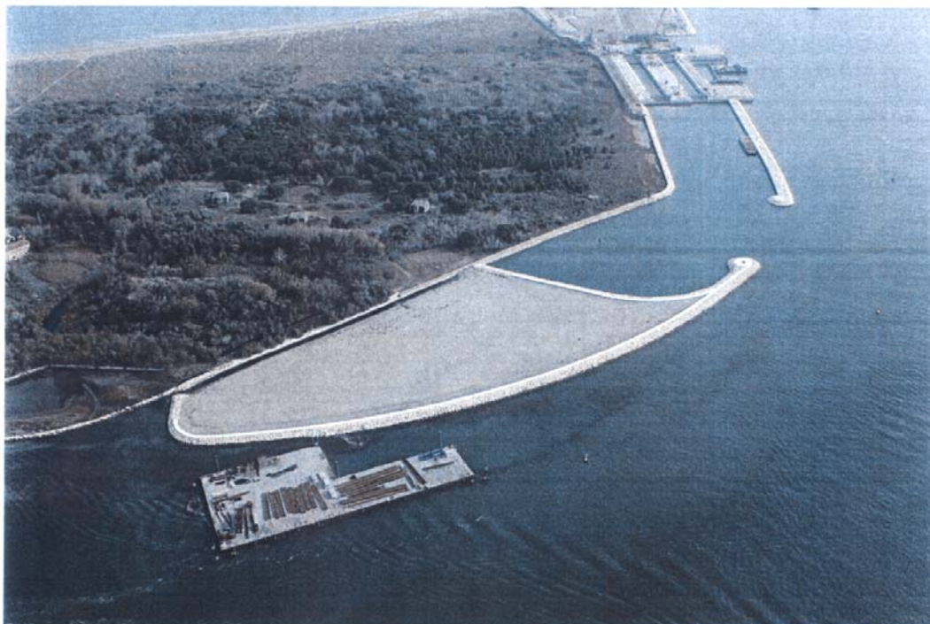
Bocca di Chioggia: la piarda per la movimentazione dei materiali (in primo piano) e il terrapieno del porto rifugio lato laguna.
