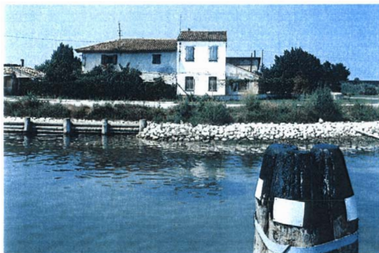
In alto e a sinistra due tratti di sponda del Canale Saccagnana dopo i lavori.
