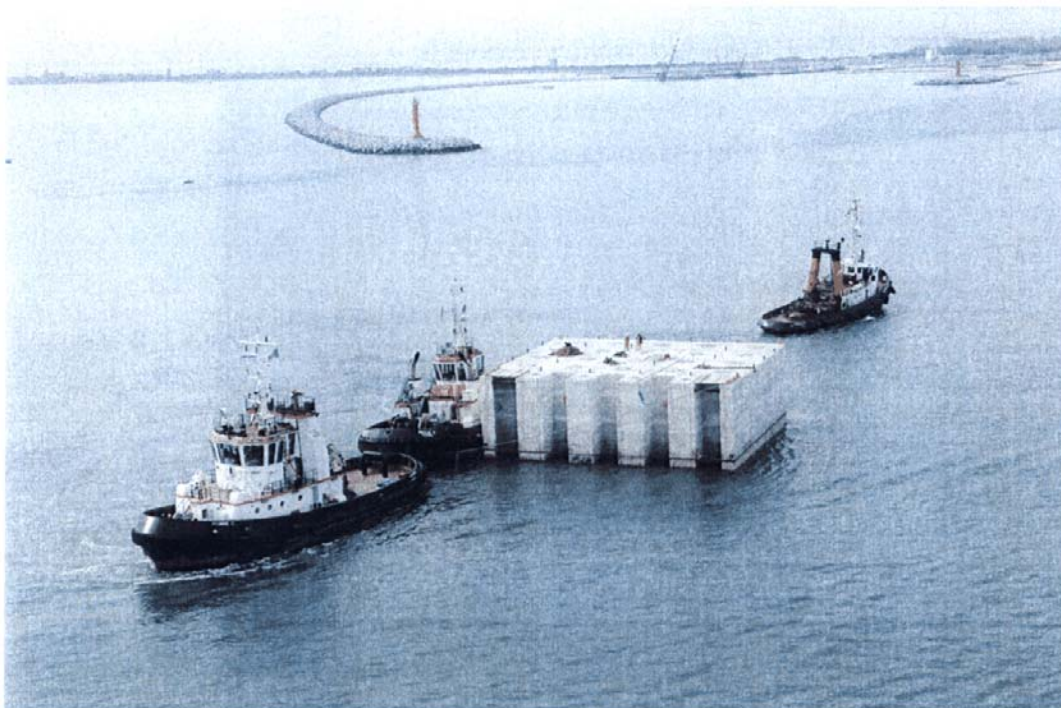
Bocca di Malamocco: fase di trasporto dei cassoni dell'impianto syncrolift.
