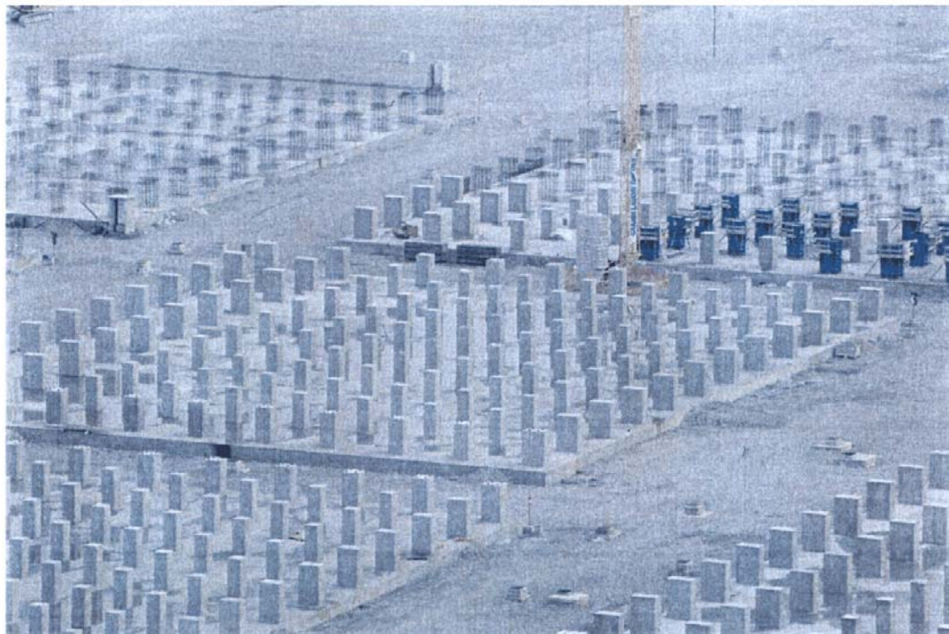
Bocca di Malamocco : particolare delle lavorazioni di realizzazione delle piastre di appoggio per la prefabbricazione dei cassoni di alloggiamento delle paratoie della barriera di S. Nicolò. In evidenza i pilastri di appoggio dei futuri cassoni.
