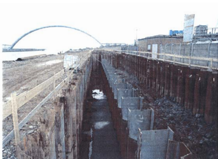
Canale Industriale sud sponda sud, sponda Fassa ex Edison. Marginamento in fase di lavorazione; palancoiato strutturale infisso all'interno della tura.
