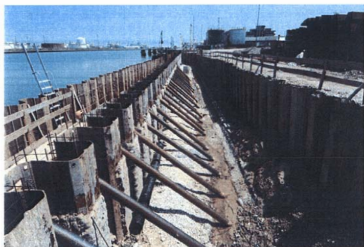
Canale Industriale sud sponda sud, area 43 ettari. Marginamento in fase di lavorazione; predisposizione tiranti sul cordolo sommitale.
