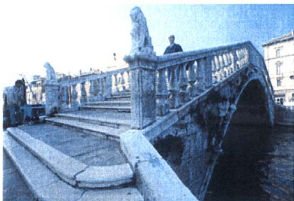
Il ponte Vigo prima dei lavori.
