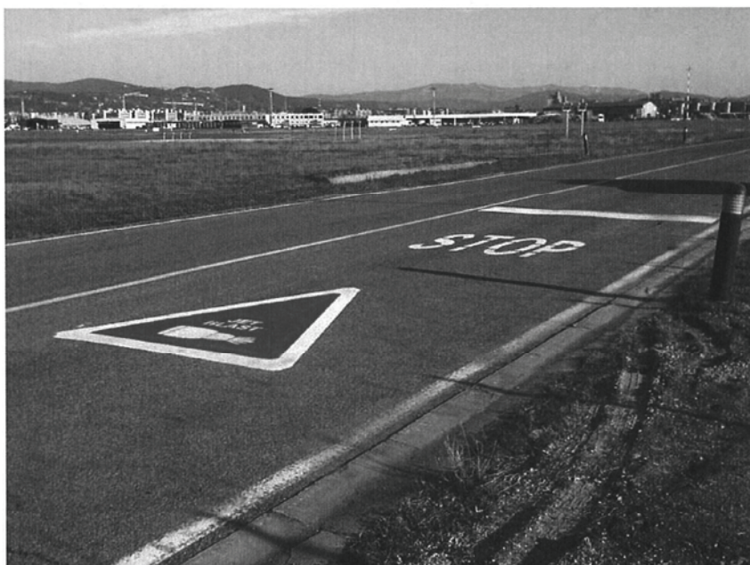
Segnaletica orizzontale apposta sulla strada perimetrale dopo l'evento del 21.1.2011 per richiamare l'attenzione sul rischio del jet blast .
