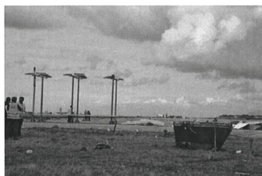
Antenna del localizzatore della pista 25, prima (a sinistra) e dopo (a destra) l'impatto dell'EI-EDM.
