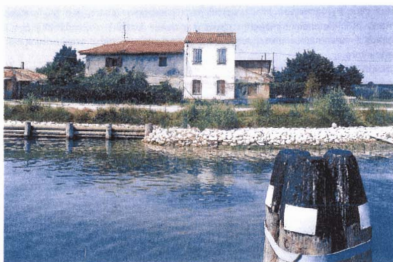
In alto e a sinistra due tratti di sponda del Canale Saccagnana dopo i lavori
