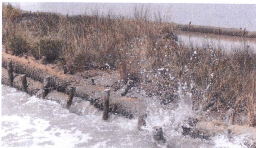
Protezione barene mediante buzzoni
