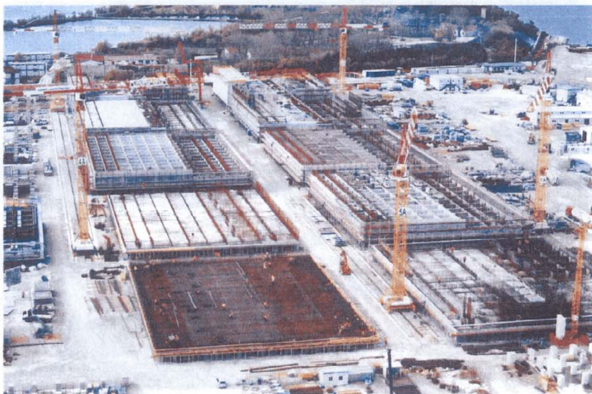
Bocca di Malamocco: Veduta delle lavorazioni di prefabbricazione dei cassoni per la bocca di Malamocco e San Nicolò
