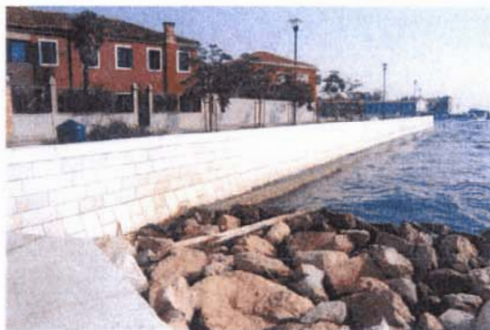
Un tratto di riva dopo i lavori
