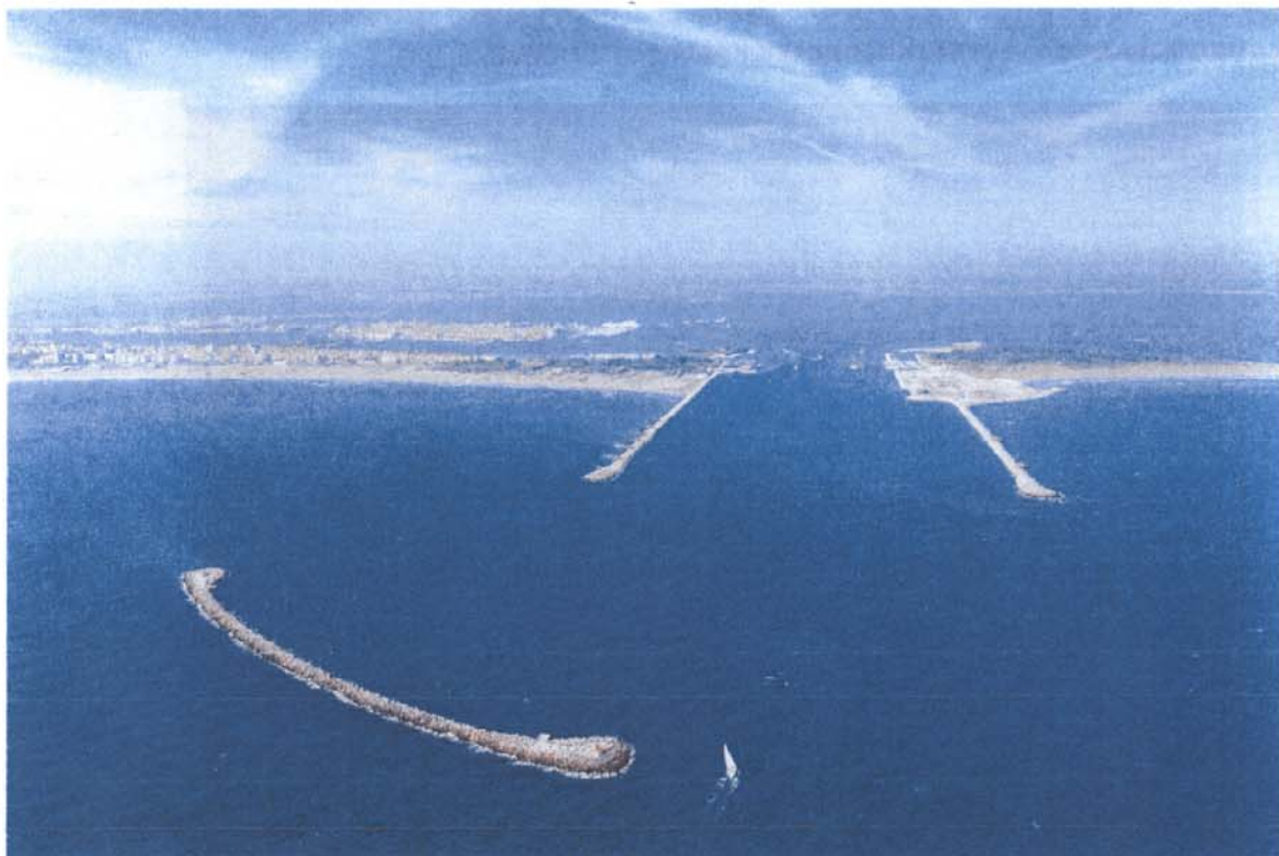
Bocca di Chioggia : veduta generale della bocca. In primo piano, la diga foranea già completata e collaudata
