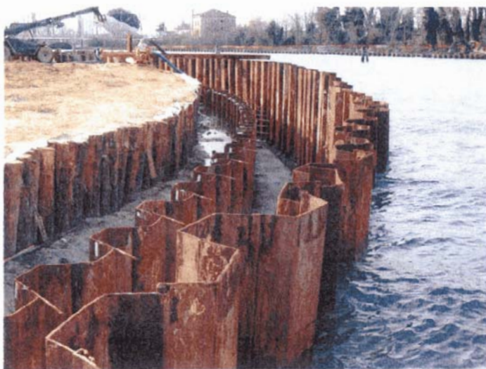
Isola delle Statue: pista perimetrale, palancolato strutturale e palancole provvisionali (sponda ovest)
