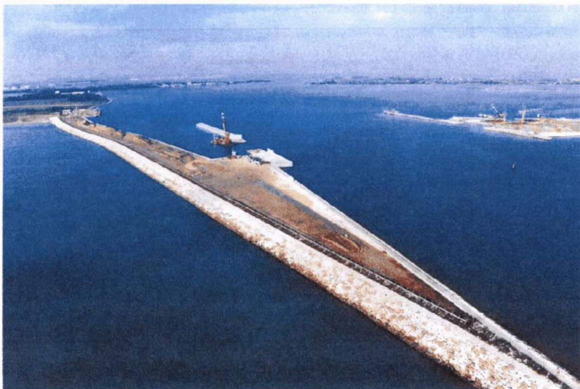
Bocca di Lido - S. Nicolò : veduta d'insieme della spalla sud. Al centro, i cassoni prefabbricati in calcestruzzo armato che costituiscono la struttura della spalla sud della barriera di S. Nicolò, già posizionati e zavorrati
