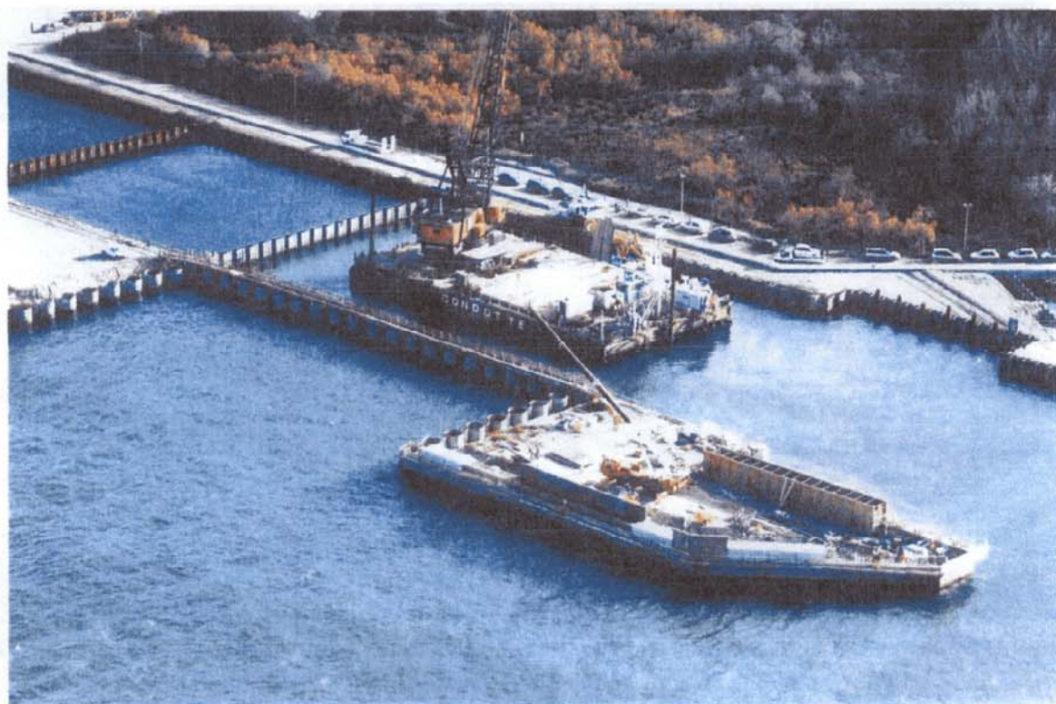
Bocca di Chioggia : particolare delle lavorazioni per la realizzazione della spalla nord della barriera di Chioggia
