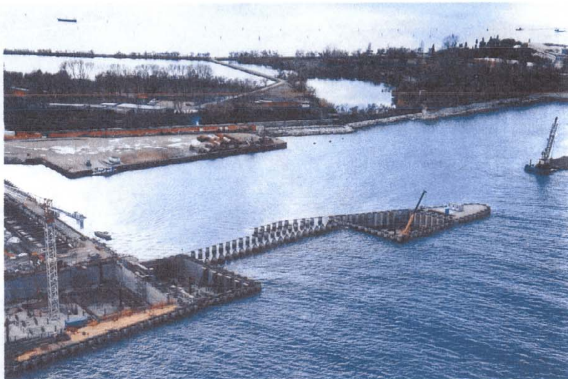
Bocca di Malamocco: particolare delle lavorazioni di infissione del palancole che formerà la spalla sud di Malamocco
