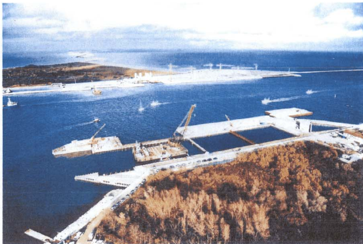
Bocca di Chioggia : in primo piano i lavori per la realizzazione della spalla nord; in secondo piano il cantiere di prefabbricazione dei cassoni
