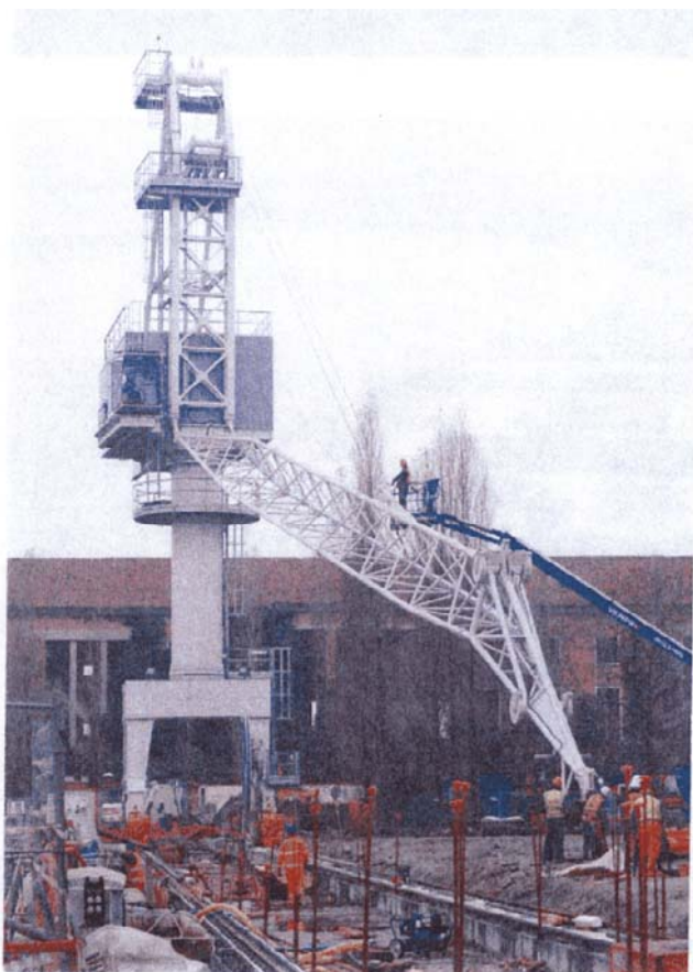
In queste foto: sopra vista del bacino durante i lavori di restauro del paramento murario con la nuova gru a servizio della sponda destra; a lato, installazione della nuova gru sempre della sponda destra del bacino medio
