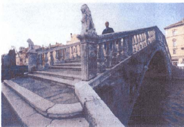
Il ponte Vigo prima dei lavori
