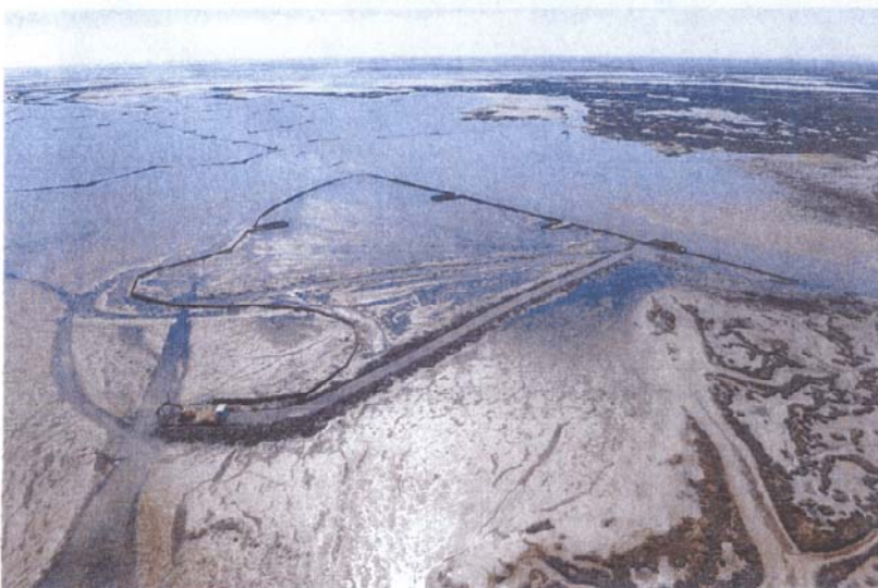
In questa foto, fase di realizzazione di un canaletto ("ghebo") per consentire il giro dell'acqua nelle varie fasi di marea
