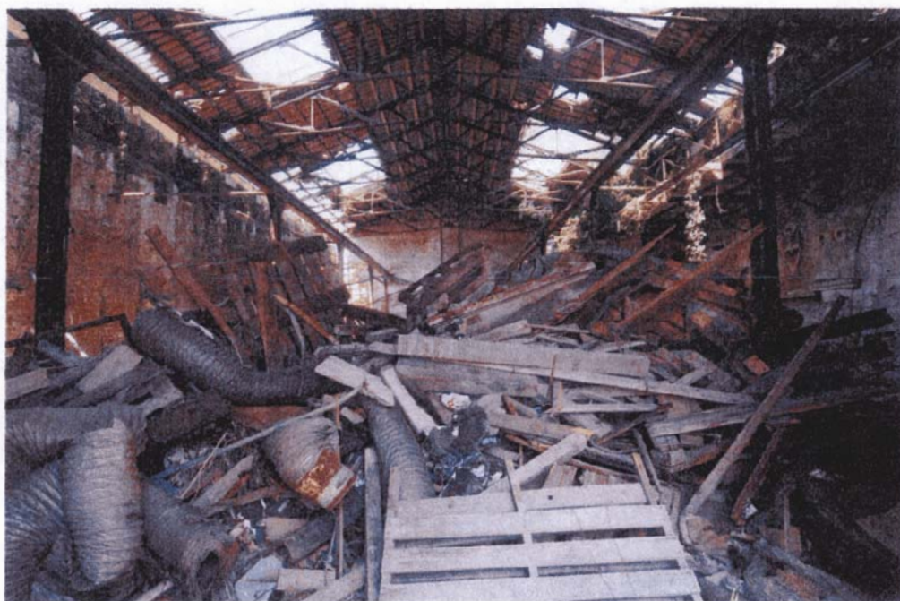
In questa foto, l'interno dell'edificio prima dei lavori
