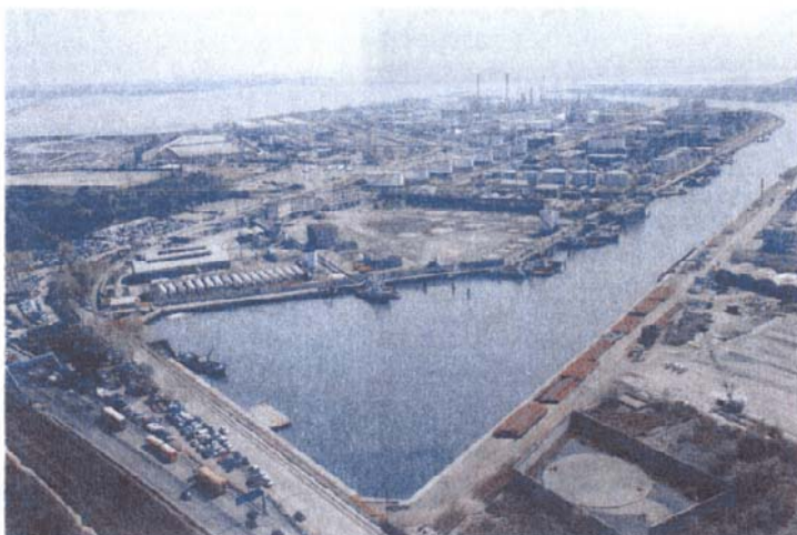
Canale Industriale Brentella vista aerea della darsena a lavori ultimati
