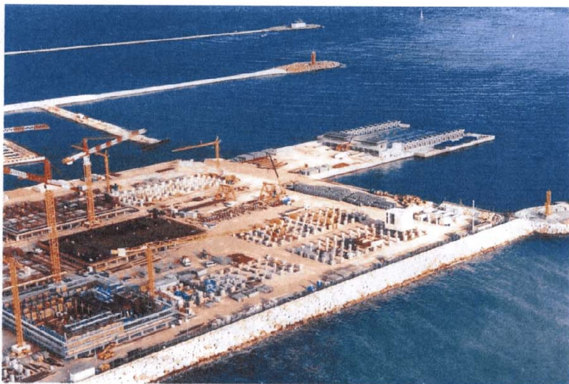
Bocca di Malamocco: veduta del rilevato sul quale vengono realizzati i cassoni prefabbricati; sullo sfondo la struttura syncrolift
