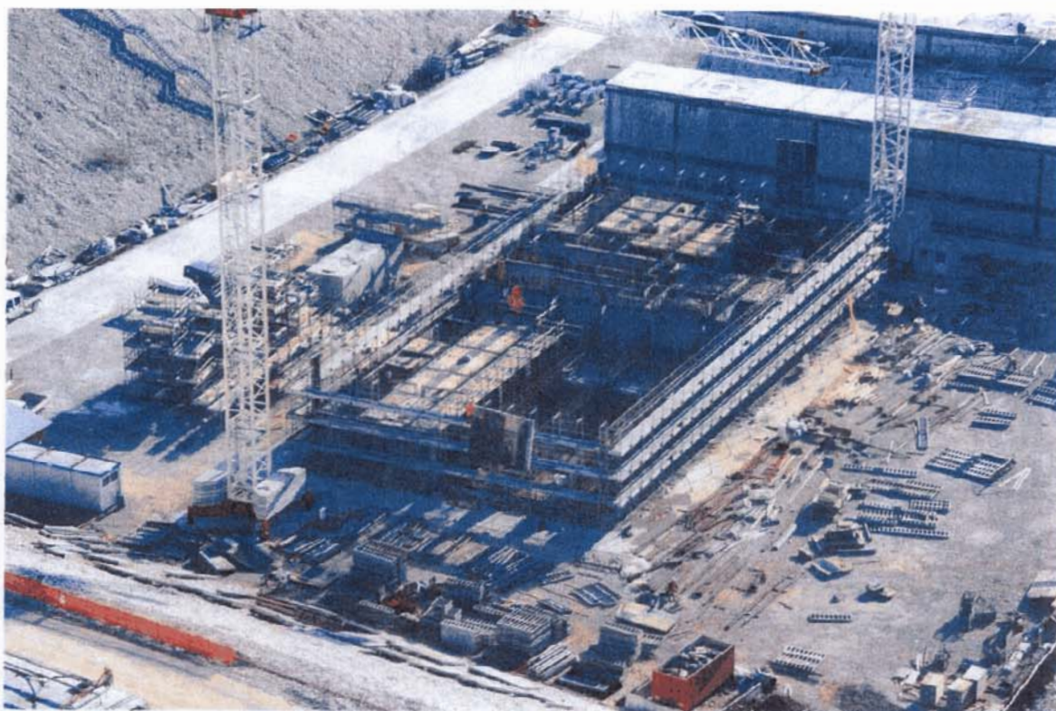
Bocca di Lido - Treporti: particolare delle attività di realizzazione di un cassone della barriera di Treporti
