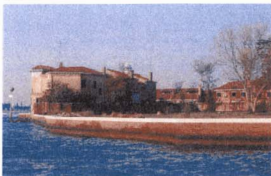
Un tratto di riva dopo i lavori nel canale Ondello
