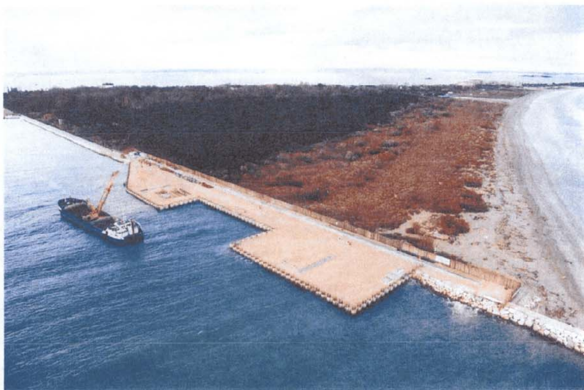
Bocca di Malamocco: particolare del lato Alberoni con il palancole in corrispondenza della spalla nord
