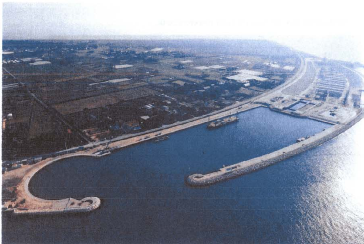
Bocca di Lido - Treporti : in primo piano, il bacino lato laguna, mentre in alto quello lato mare messo all'asciutto per essere utilizzato come tura per la prefabbricazione dei cassoni, sui quali verranno incernierate le paratoie della barriera di Treporti
