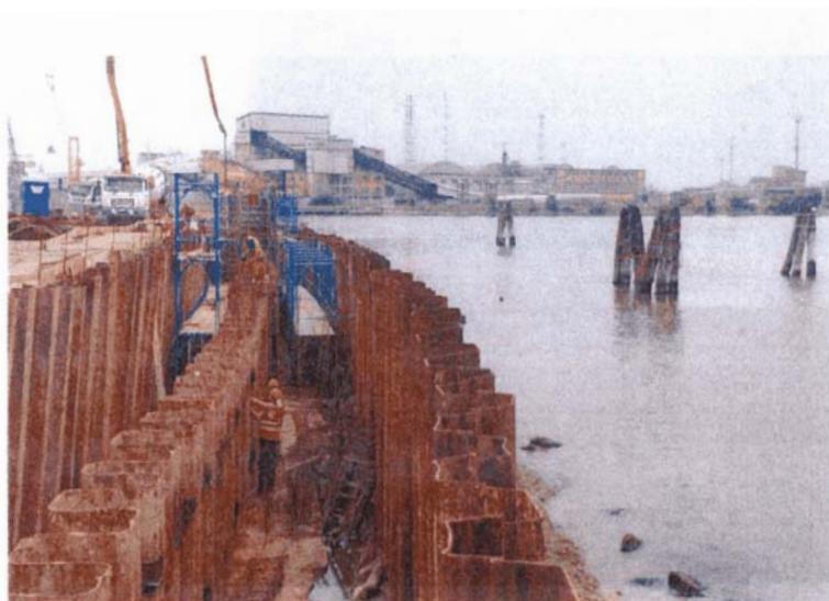
Canale Industriale Ovest sponda est: palancolato strutturale infisso all'interno delle ture provvisionali
