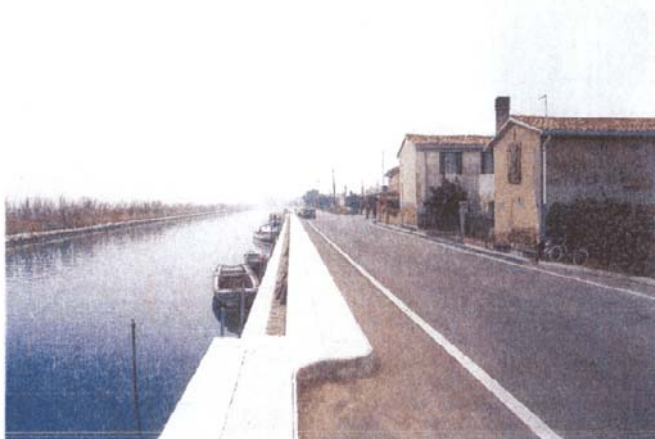
Lo stesso tratto di sponda a lavori ultimati
