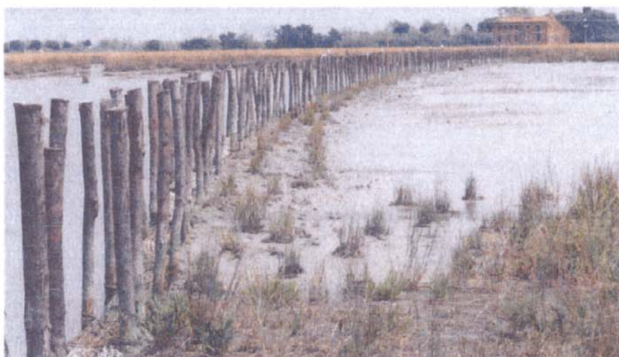
Protezione barene mediante fascinate
