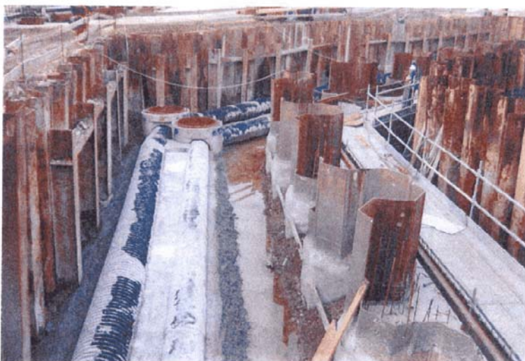
Canale Industriale Sud sponda sud e darsena terminale tratto Pagnan - Colacem: realizzazione del cordolo di sommità al palancolato strutturale e inserimento condotte Pif all'interno delle ture provvisionali
