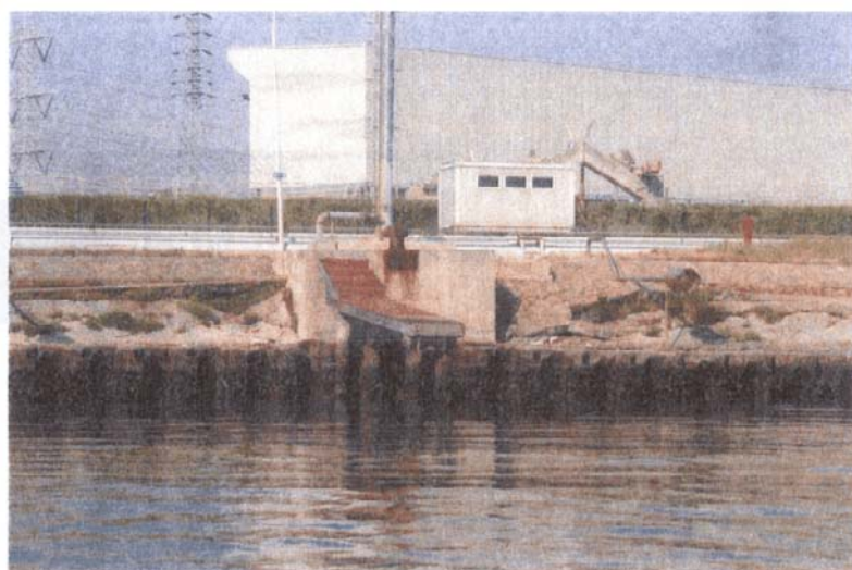
Canale Industriale Sud darsena terminale: stato di fatto di un tratto di marginamento
