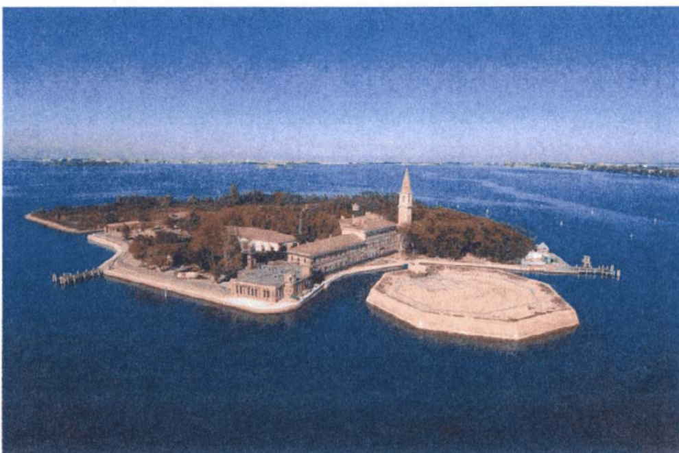
Due immagini dell'isola prima e dopo i lavori
