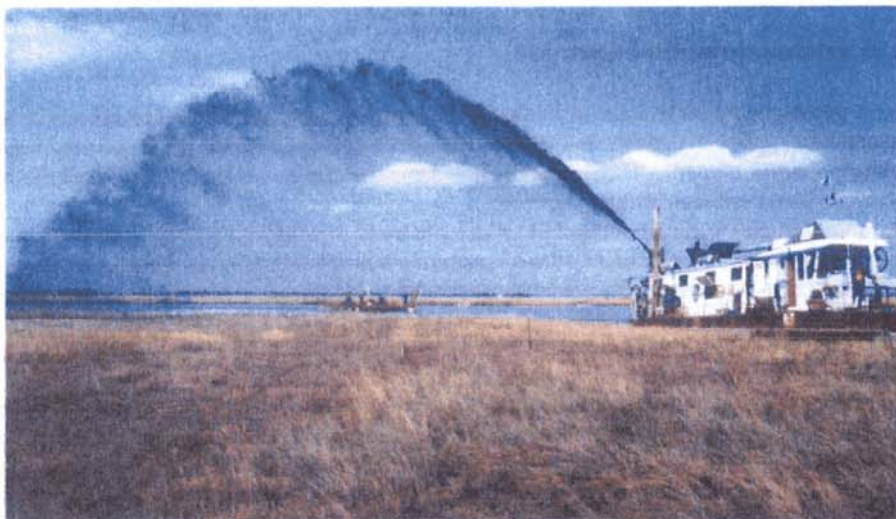
Protezione barene mediante rinascimento
