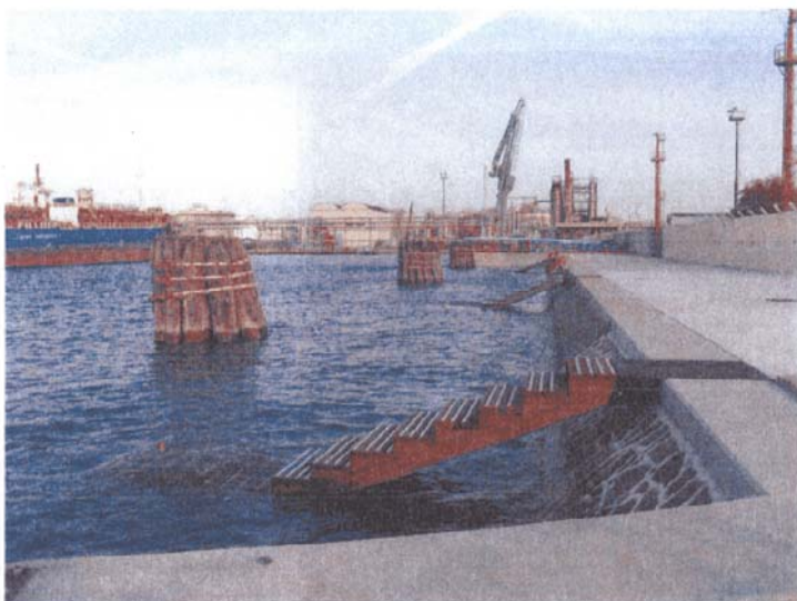
Sponda nord del Canale Vittorio Emanuele III, tratto di marginamento ultimato in Darsena Eni
