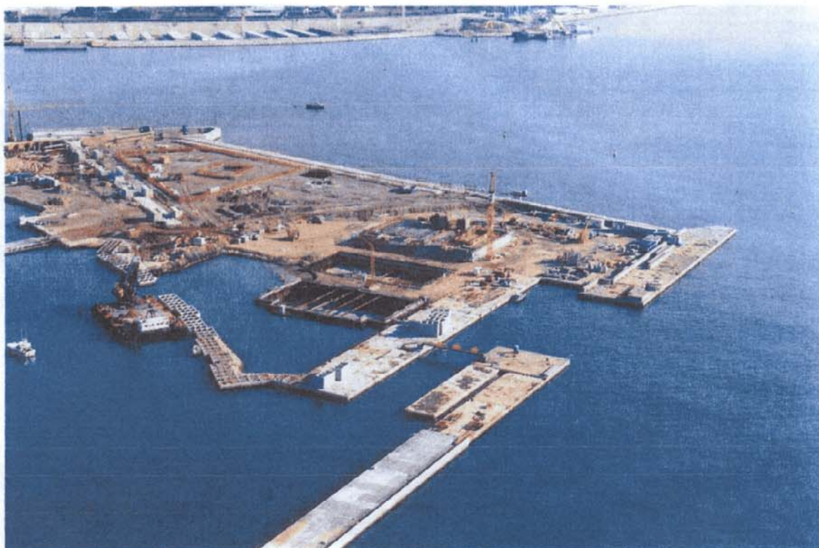
Bocca di Lido : particolare dei cassoni affondati e zavorrati che formano, nella nuova isola, la spalla nord della barriera di San Nicolò
