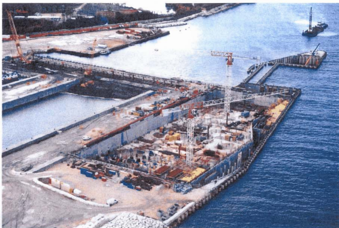
Bocca di Malamocco: vasca per gli impianti in corrispondenza della spalla sud
