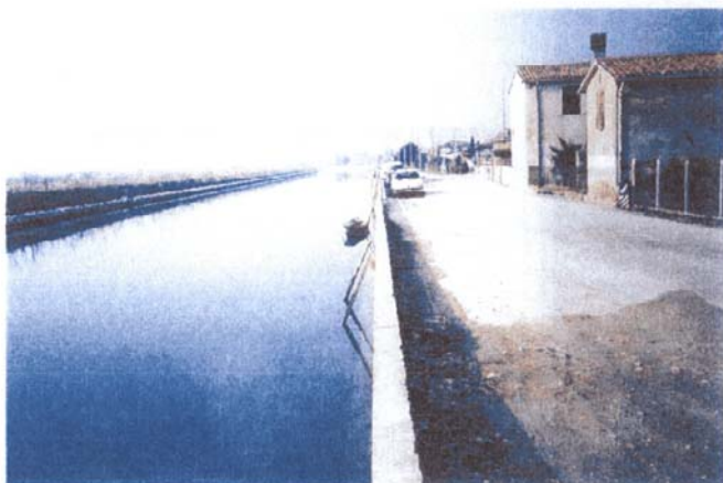
Un tratto di sponda prima dei lavori
