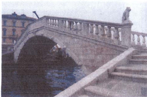
Il ponte Vigo dopo i lavori
