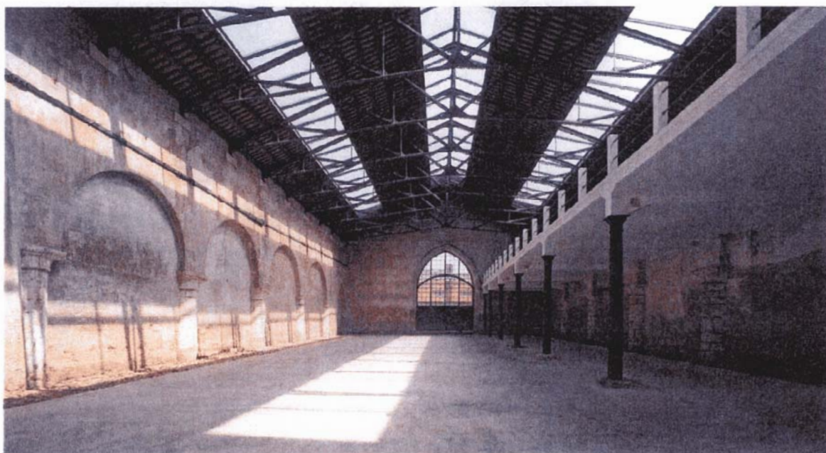
In questa foto, l'interno dell'edificio dopo i lavori di messa in sicurezza e recupero
