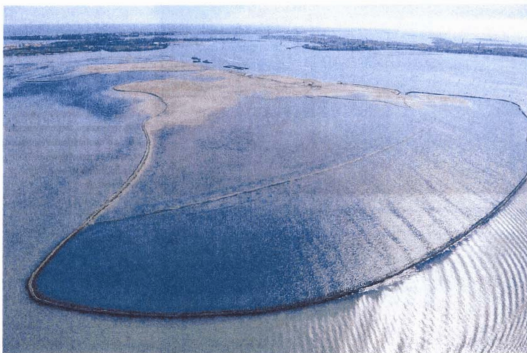
In queste foto, le diverse tipologie di contenimento delle barene con burghes di vario tipo, l'opera soffolta a protezione del moto ondoso realizzata sempre in burghes e materassi
