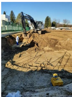
Ispra – Cantiere di scavo dell'impianto di recupero
