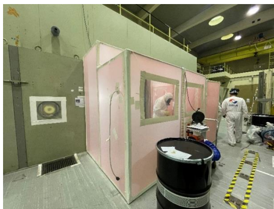
Ispra – Decontaminazione di celle calde nell'LCSR
