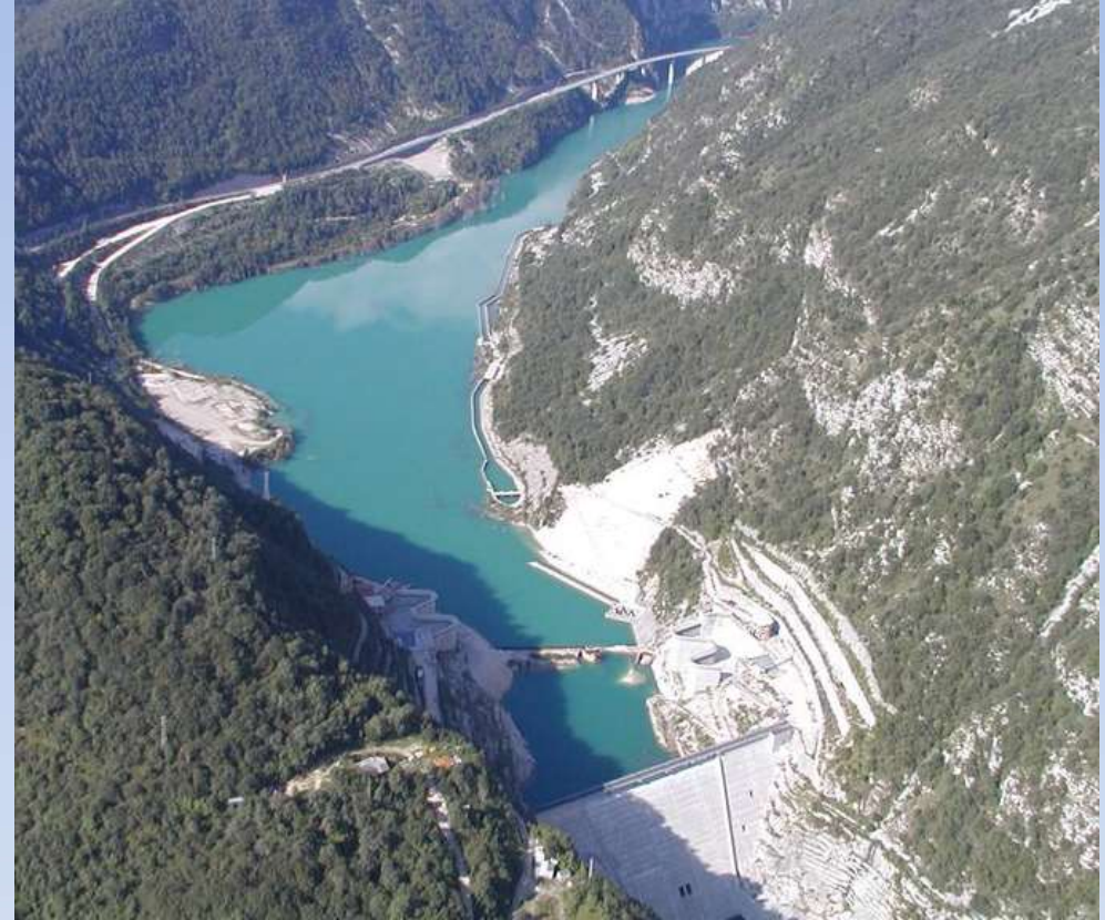
DIGA DI RAVEDIS
