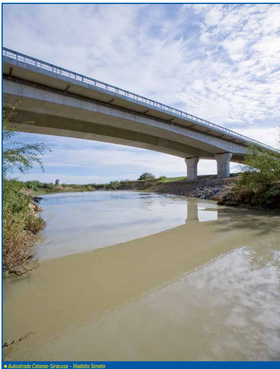
■ Autostrada Catania-Siracusa - Viadotto Simeto
