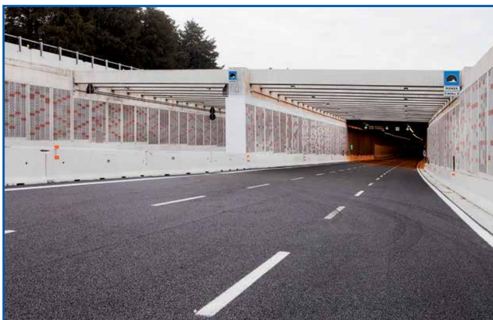
■ S.S.36 "del Lago di Como e dello Spluga" - Galleria Monza
