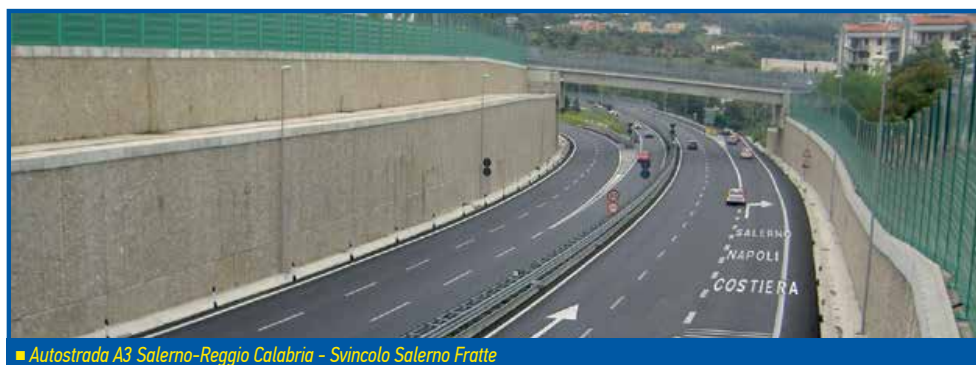
■ Autostrada A3 Salerno-Reggio Calabria - Svincolo Salerno Fratte
