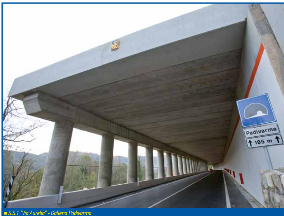
■ S.S.1 "Via Aurelia" - Galleria Padivarma
