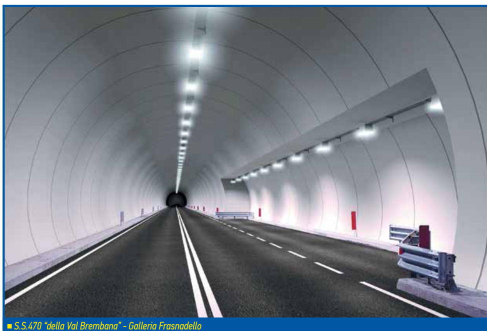
■ S.S.470 "della Val Brembana" - Galleria Frasnadello
