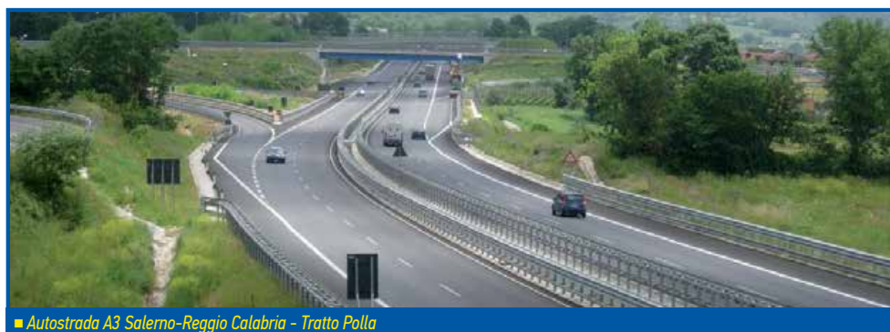
■ Autostrada A3 Salerno-Reggio Calabria - Tratto Polla
