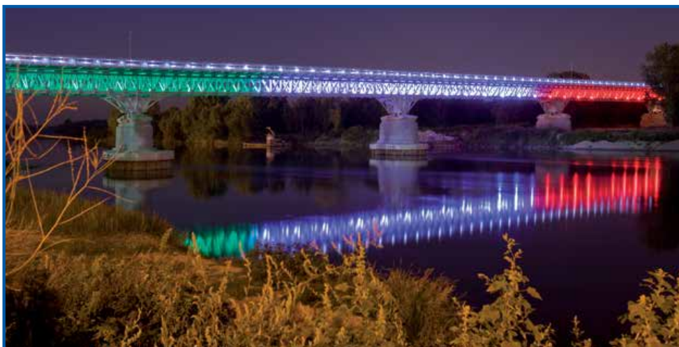
■ S.S.9 "Via Emilia" - Ponte sul Fiume Po
