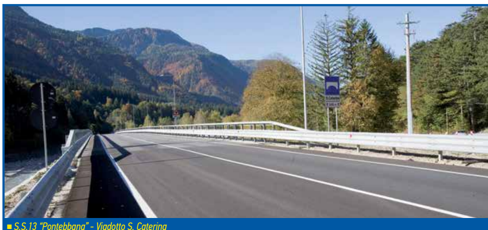
■ S.S.13 "Pontebbana" - Viadotto S. Caterina
