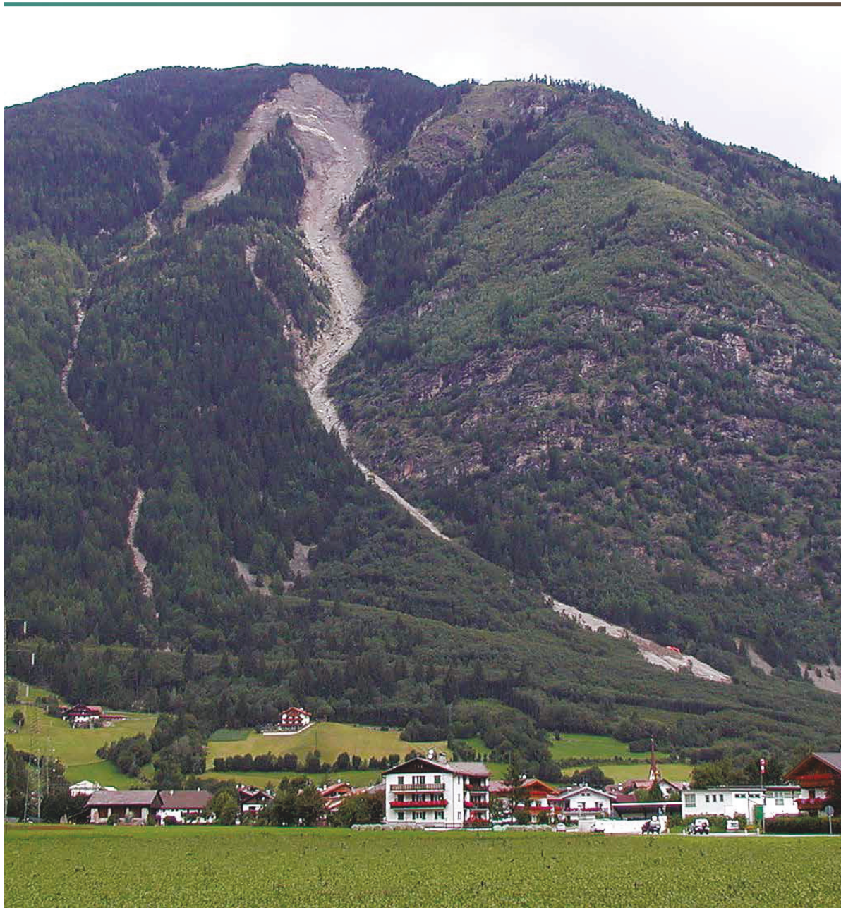
Foto 8.18 Frana sovrastante l'abitato di Molini di Tures - Intervento 084/99 - Campo Tures (BZ) Fonte ISPRA Elisa Brustia - Roberto Pompili
