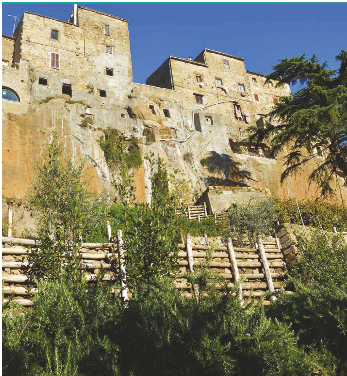
Foto 8.19 Consolidamento rupe tufacea - Intervento 431/02 - Pitigliano (GR) Fonte ISPRA Daniele Spizzichino - Francesco Traversa
