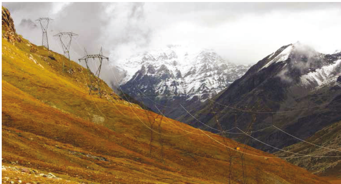
Foto 2.08 Tralicci elettrici Fonte ISPRA - Paola Orlandi
