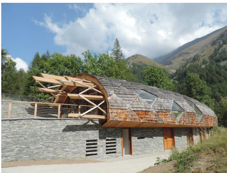
Fig. 7-2 - L'edificio del Centro, in fase di conclusione dei lavori. Foto B. Rosai
