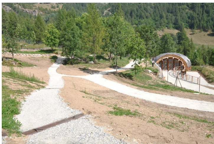
Fig. 4-23 -Area esterna del centro visitatori "L'uomo ed i coltivi" con i lavori strutturali terminati (Foto M.Ottino)
