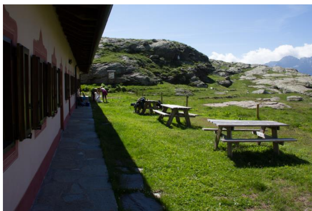
Fig. 8-4 - Manutenzioni presso la Casa di caccia del Gran Piano di Noasca. Foto B. Rosai
