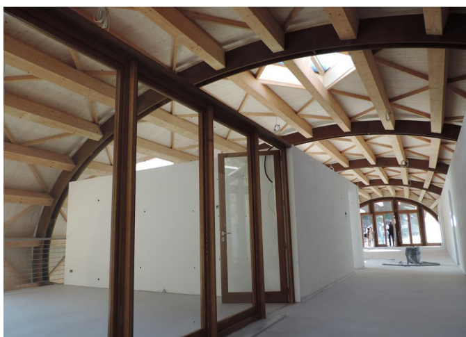
Fig.7-4 -L'interno della zona centrale del fabbricato. Foto B. Rosai
