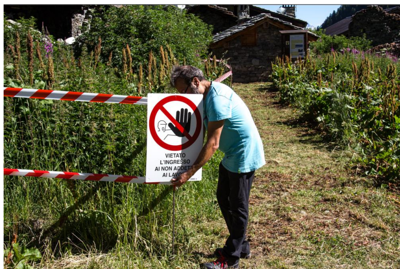
Fig. 8-3 - Messa in sicurezza di struttura pericolante a Thumel. Foto Archivio PNGP
