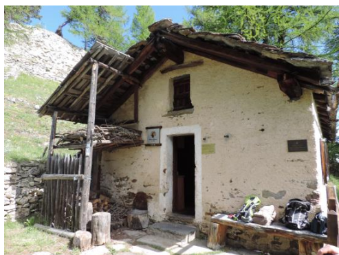
Fig. 8-5 - Progettazione dei lavori sul Casotto del Mont Blanc. Foto B. Rosai
