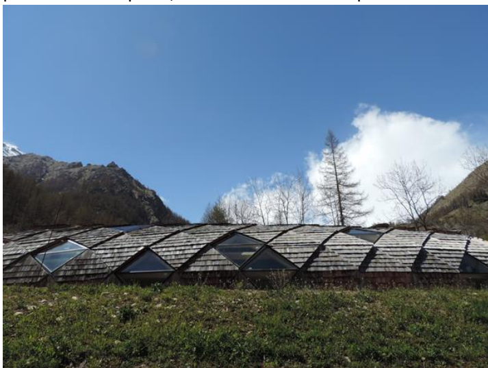
Fig. 7-3 - Un particolare del tetto ad embrici di scandole del fabbricato.
