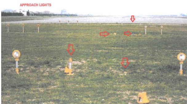
Foto dei danni alle luci del sistema luminoso di avvicinamento e all’antenna del localizer .
