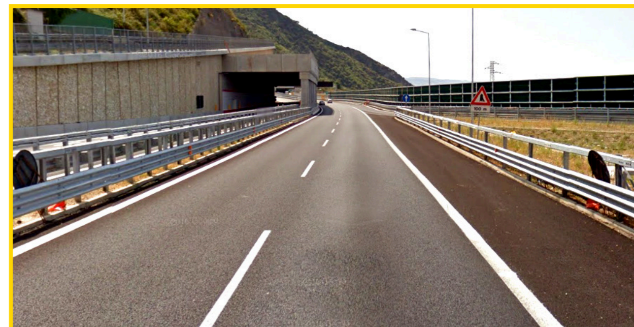
A2 "Autostrada del Mediterraneo" - Svincolo Scilla
