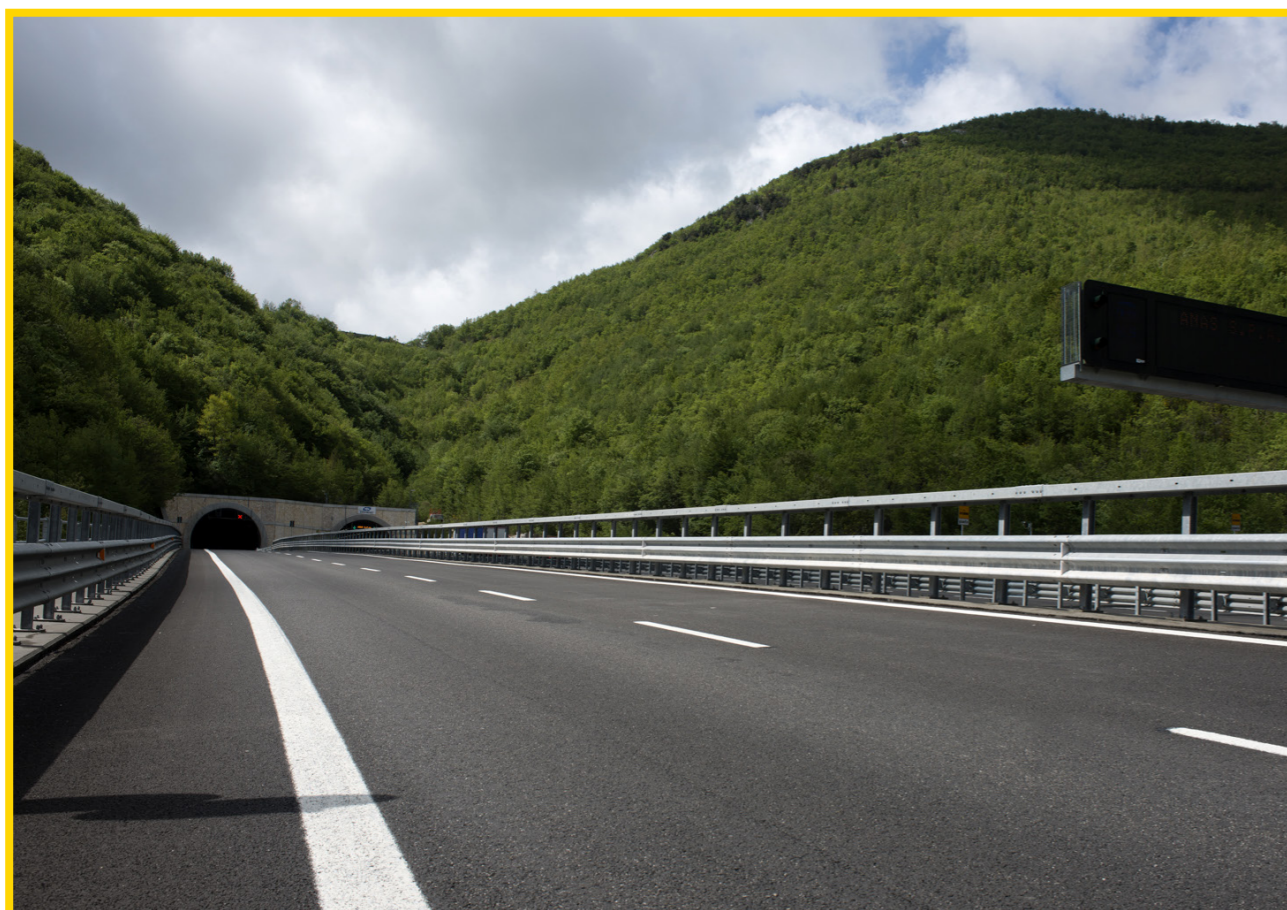
A2 "Autostrada del Mediterraneo" - Galleria Fossino
