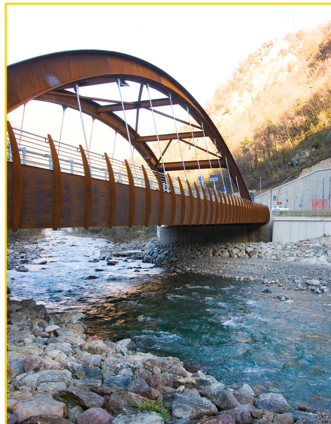
S.S.42 "Del Tonale e della Mendola" - Ponte Allione
