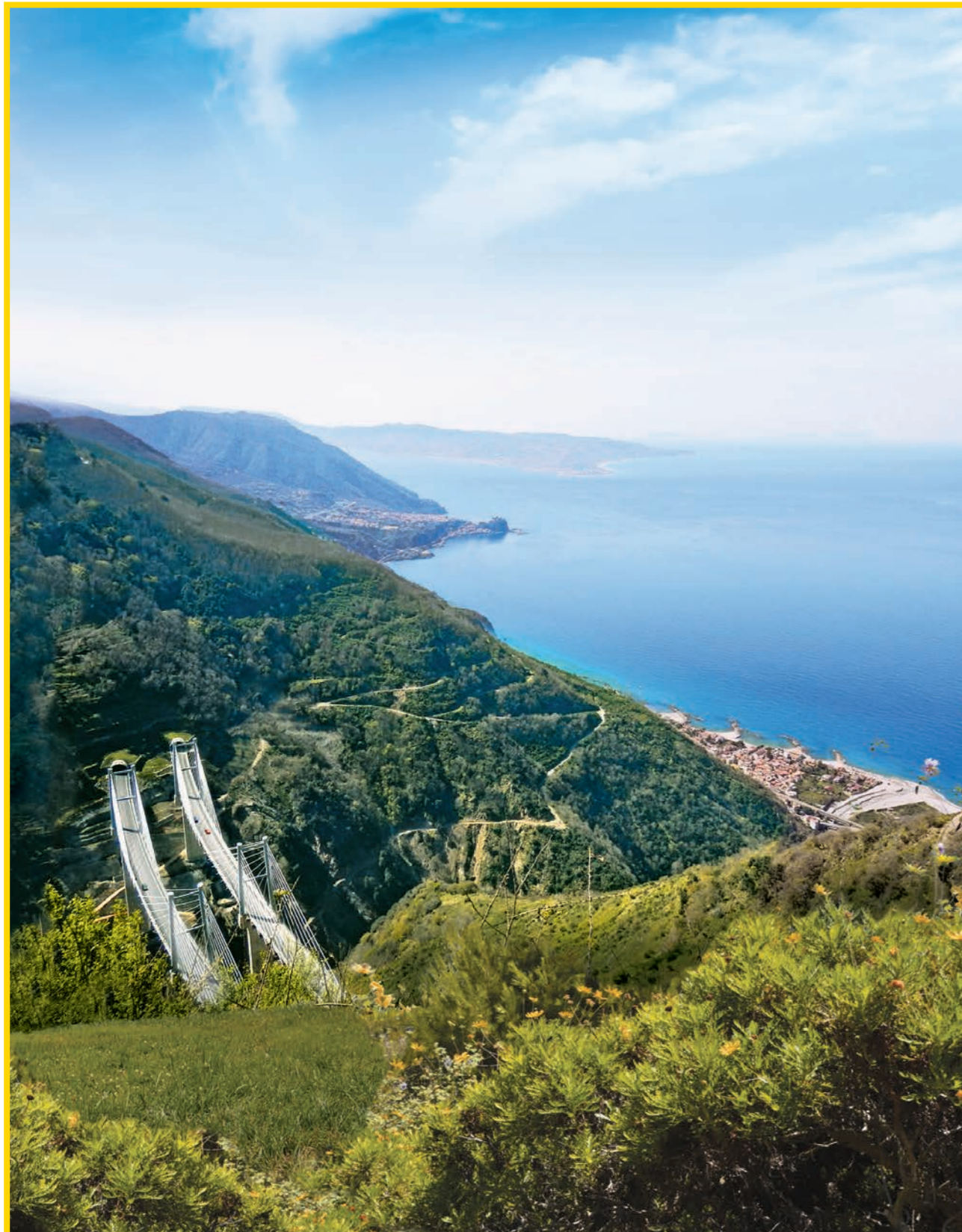
A2 "Autostrada del Mediterraneo" - Viadotto Favazzina
