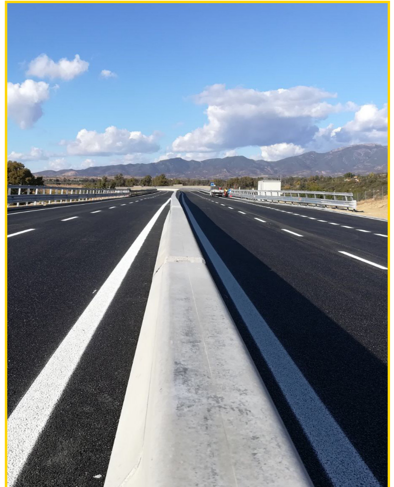
S.S.554 “Cagliaritana” - Tratto tra gli svincoli di Gianní e Santu Lianu
