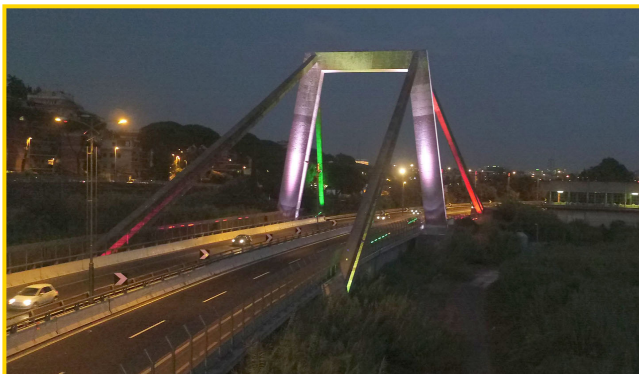
A91 "Autostrada Roma- Aeroporto di Fiumicino" - Ponte Morandi
