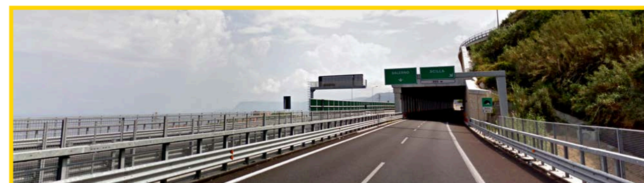
A2 "Autostrada del Mediterraneo" - Svincolo Scilla
