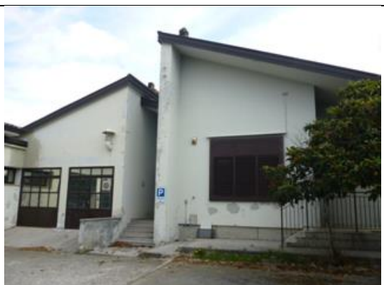
Esterno edificio principale Parte B
