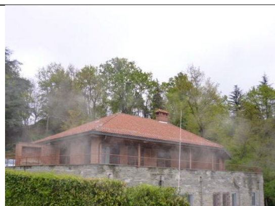
Esterno fabbricato "Villa"
