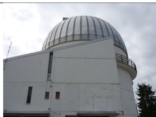
Edificio Cupola 182 (Esterno)
