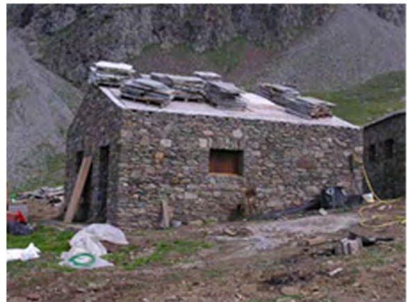
Lavori di manutenzione lungo la Tappa 1-550 da loc. Loseraì al Rifugio Città di Chivasso, Ceresole Reale
