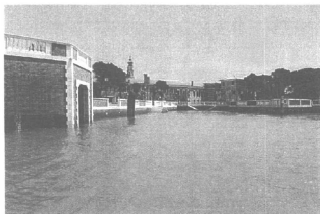
Isola degli Armeni. Le nuove rive attrezzate della darsena.
