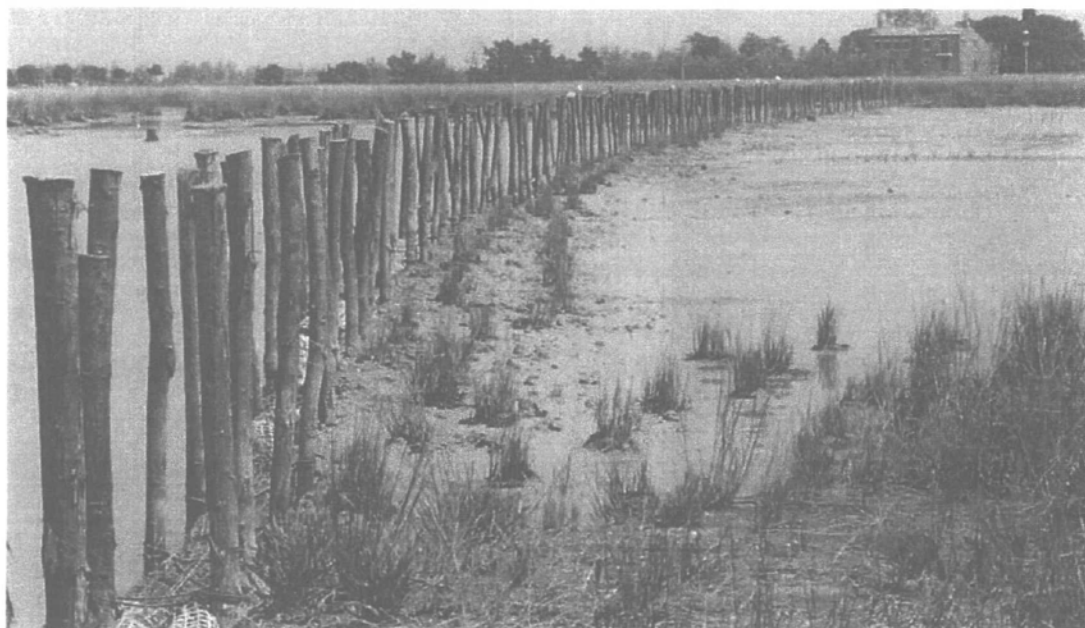
Protezione barene mediante fascinate.
