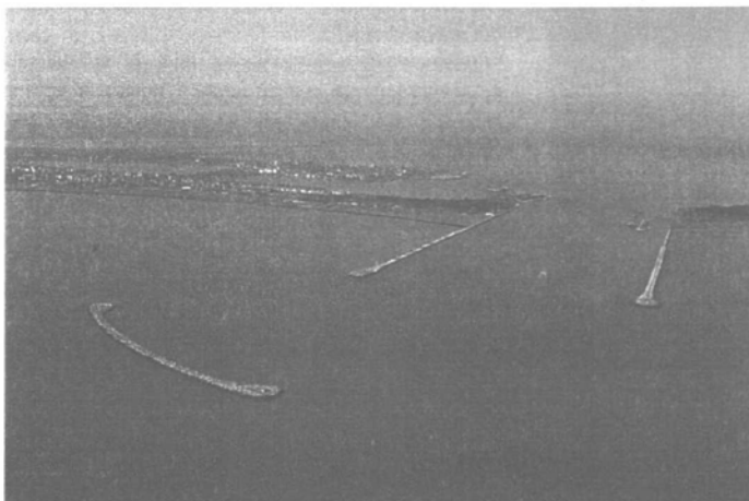
Bocca di Chioggia - Diga Foranea
