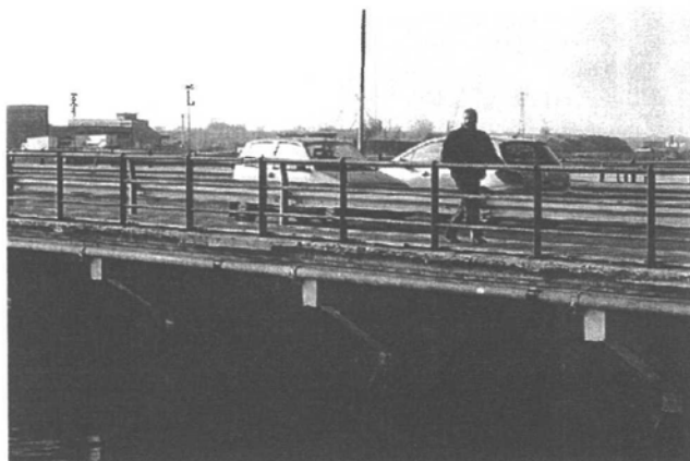
Il ponte prima degli interventi.
