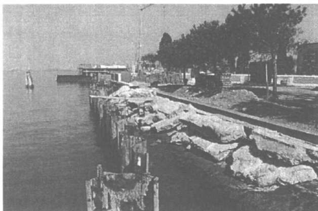
Isola degli Armeni. Un tratto della sponda sud-ovest durante i lavori.
