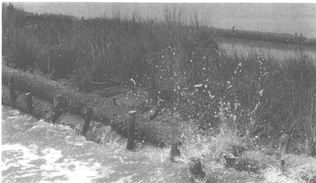
Protezione barene mediante buzzoni.
