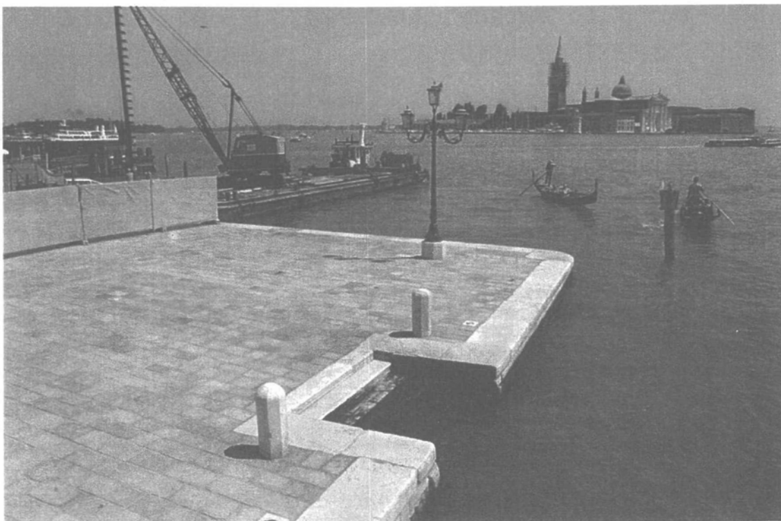
Difesa rive bacino S. Marco tra Ponte della Paglie e Ponte del Vin. Un tratto della riva a lavori ultimati.
