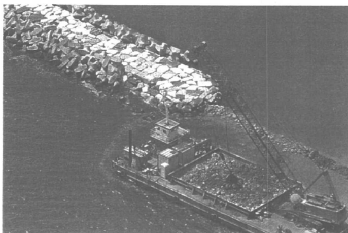
Bocca di Malamocco- Diga foranea. Mezzi in opera.
