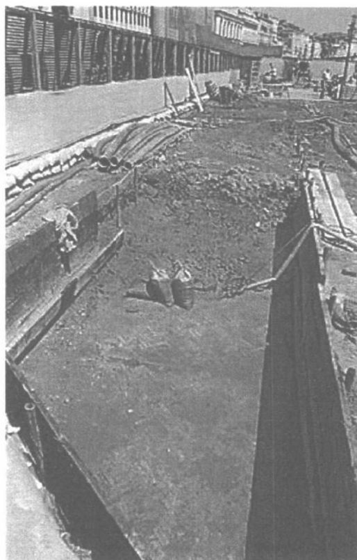
Difesa Insula San Marco 1° stralcio. Ritrovamento di antiche pavimentazioni durante i lavori.
