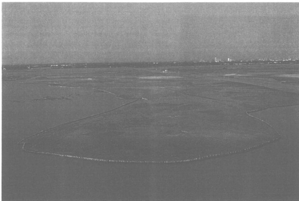
Lago Teneri. Vista aerea della zona di intervento durante i lavori di ripristino della barena.
