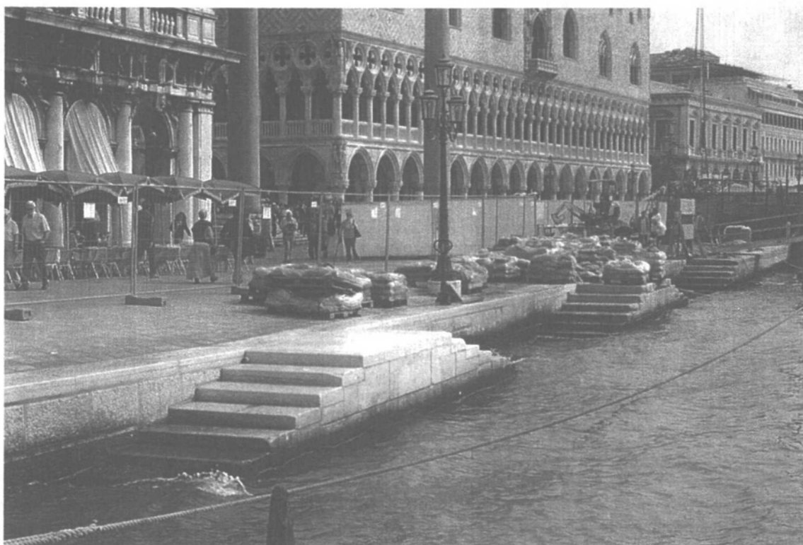
Difesa Insula S. Marco 1° stralcio. Vista del molo durante i lavori.
