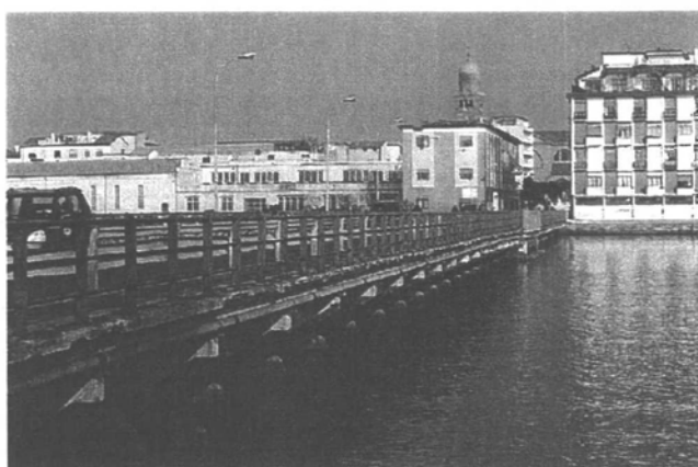
Il ponte prima degli interventi.
