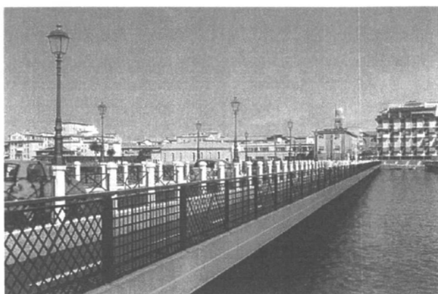
Il ponte dopo i lavori di ristrutturazione e adeguamento.
