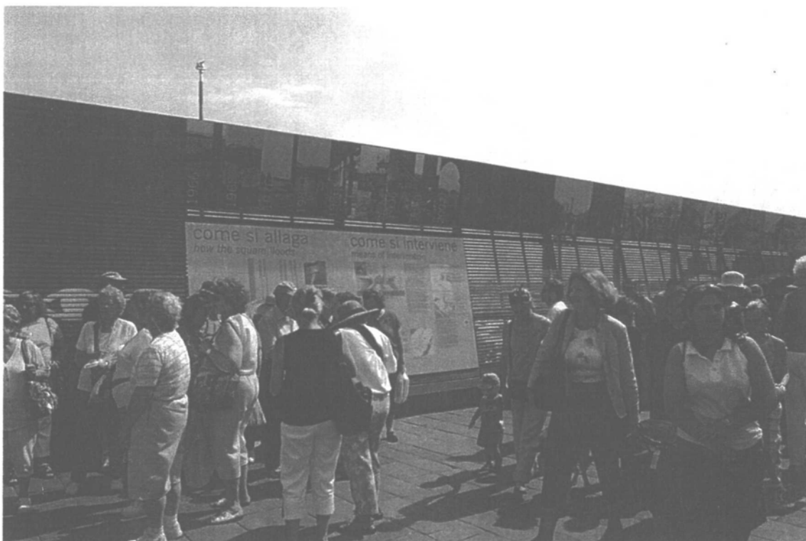
Difesa Insula S. Marco 1° stralcio. L'area di cantiere e l'allestimento della recinzione con pannelli descrittivi degli obiettivi dei lavori e delle modalità esecutive.
