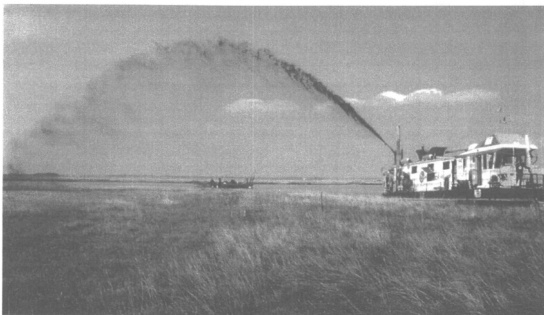
Protezione barene mediante ripascimento.
