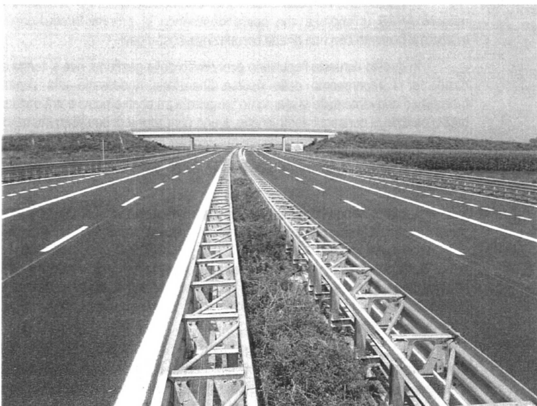
Autostrada Asti - Cuneo
