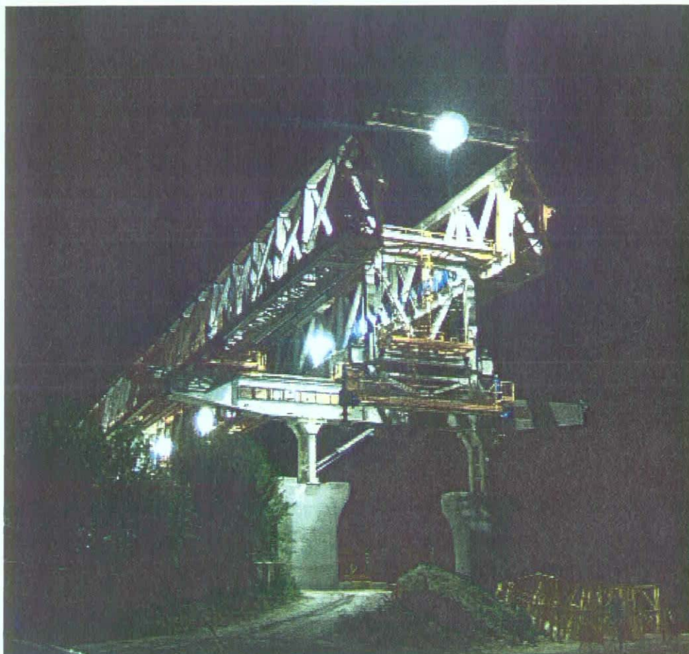
Catania-Siracusa Lotto 1 Viadotto Porcaria carro varo ripreso durante i lavori notturni
