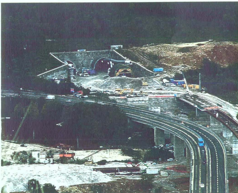
Autostrada Salerno-Reggio Calabria visuale imbocchi nord galleria Costa Inconata
