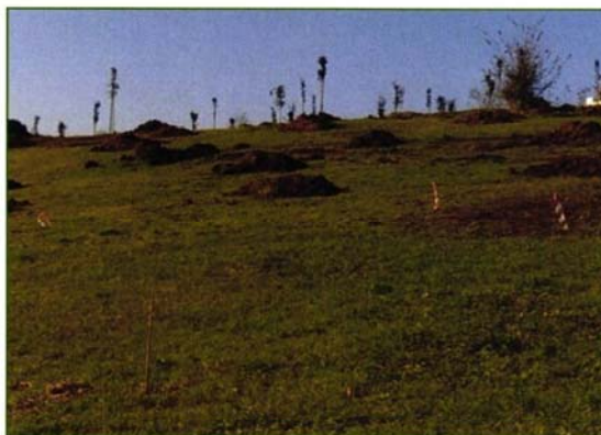
Esempio di tracciamento con paletti e nastro segnaletico in un'area verde di Roma
