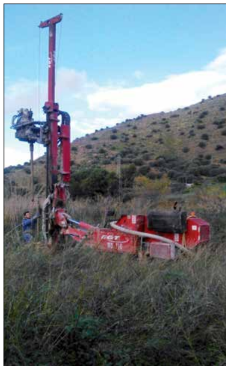
Figura 3 - Realizzazione di sondaggi per prelievo di campioni in profondità
