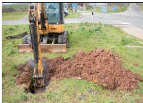
Figura 1 - Scavo di pozzetti esplorativi per il prelievo di campioni di terre per caratterizzazione ambientale
