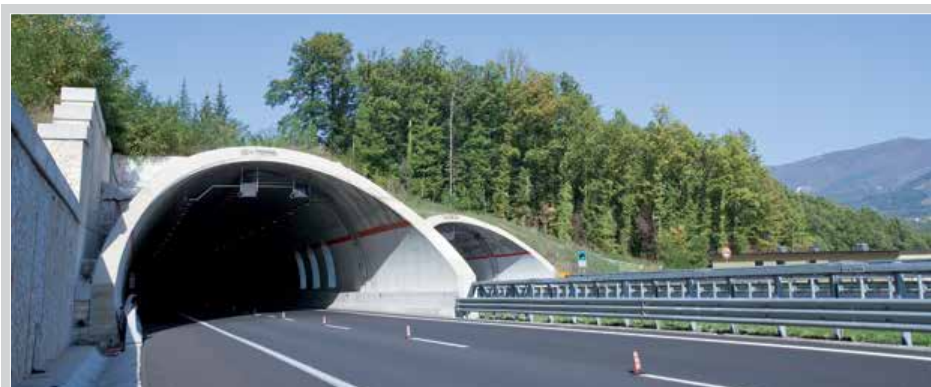
■ Autostrada A3 Salerno-Reggio Calabria - Galleria Cerreta Nord
