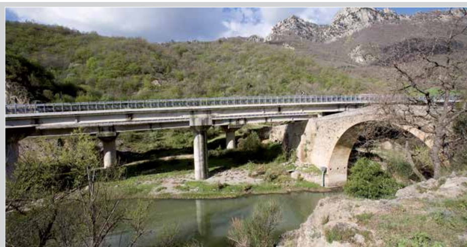
■ S.S. 407 "Basentana" - Ponte della Vecchia
