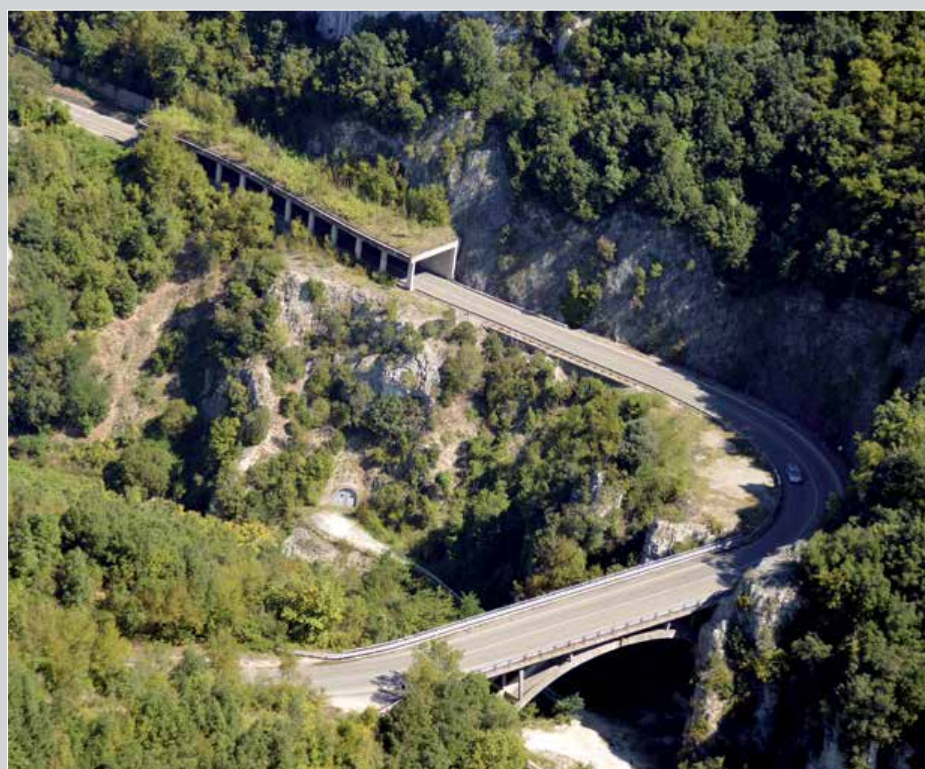
■ S.S. 448 "di Baschi" - Ponte della Pasquarella
