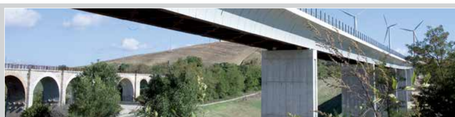
■ S.S. 87 "Sannitica" - Viadotto Macchia della Selva
