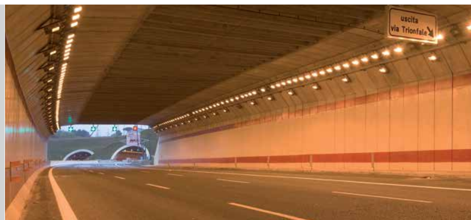
■ Autostrada del Grande Raccordo Anulare di Roma - Galleria Cassia
