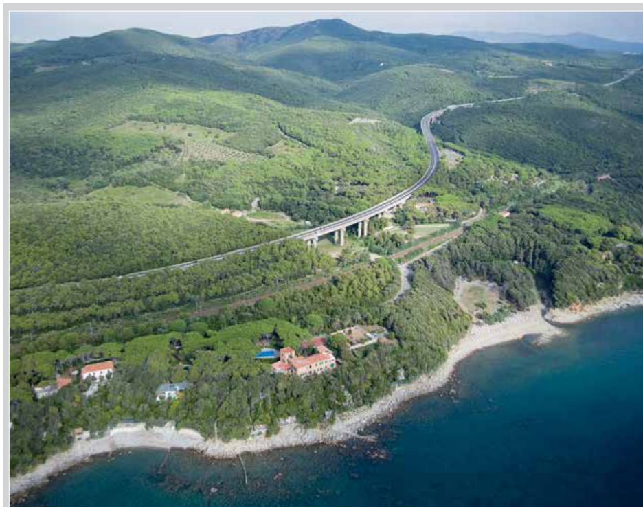
■ S.S. 1 "Aurelia" - Viadotto Fortulla
