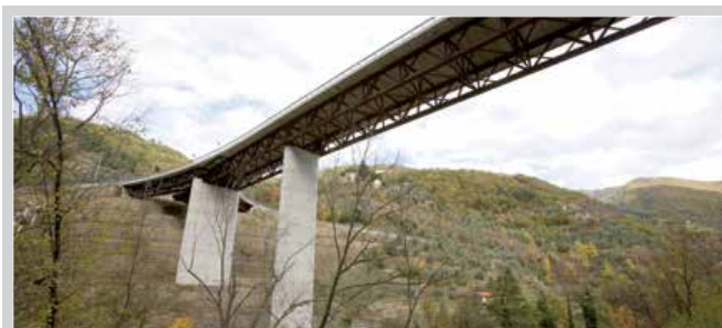
■ S.S. 28 "del Colle di Nava" - Viadotto Arroscia
