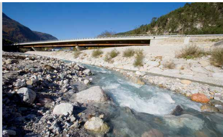
■ S.S. 13 "Pontebbana" - Viadotto S. Caterina
