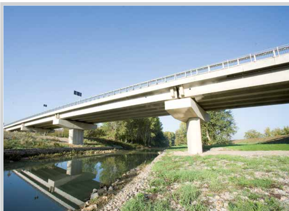
■ Ex S.S. 429 "di Val d'Elsa" - Viadotto Fiume Elsa
