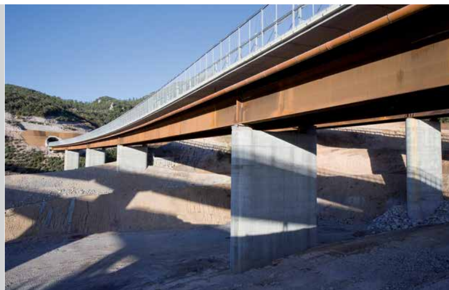
■ Autostrada A3 Salerno-Reggio Calabria - Viadotto Caballa
