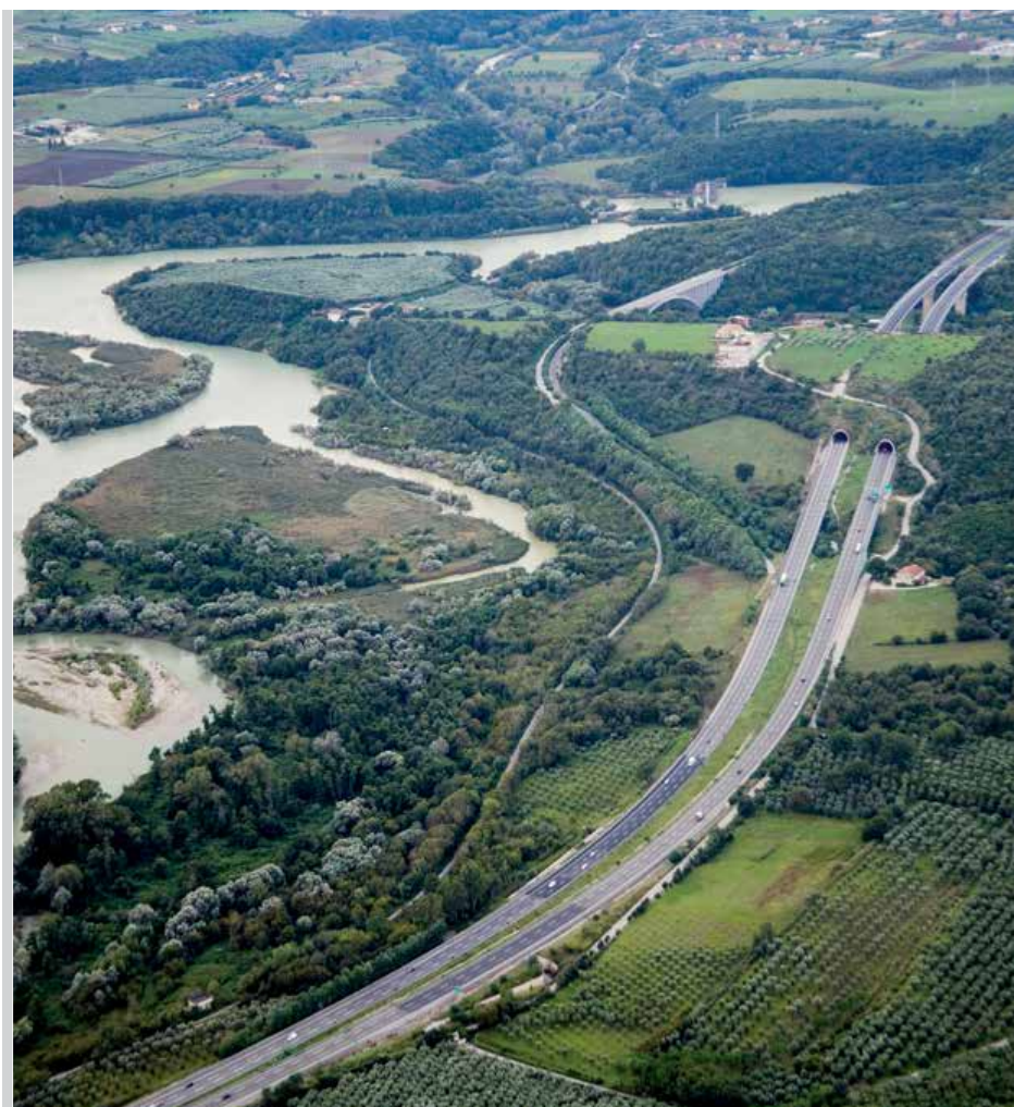
■ Autostrada A3 Salerno-Reggio Calabria - Galleria Persano
