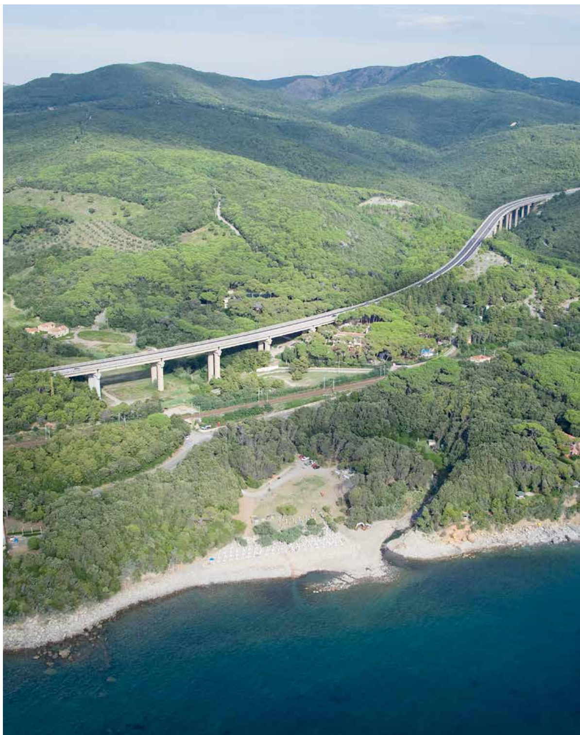
■ S.S. 1 "Aurelia" - Località Fortullino Due Viadotti
