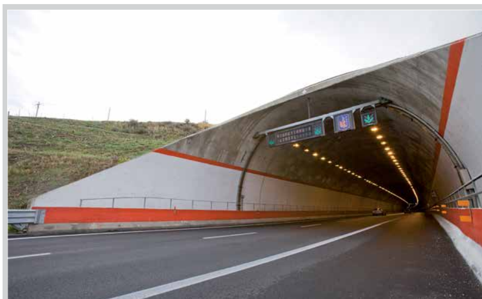
■ Autostrada Catania-Siracusa - Galleria S. Demetrio
