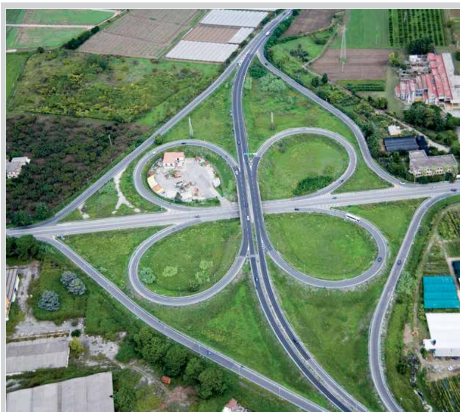
■ Autostrada A3 Salerno-Reggio Calabria - Tratto Eboli-Contursi
