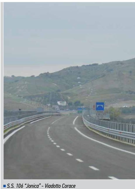
■ S.S. 106 "Jonica" - Viadotto Corace
