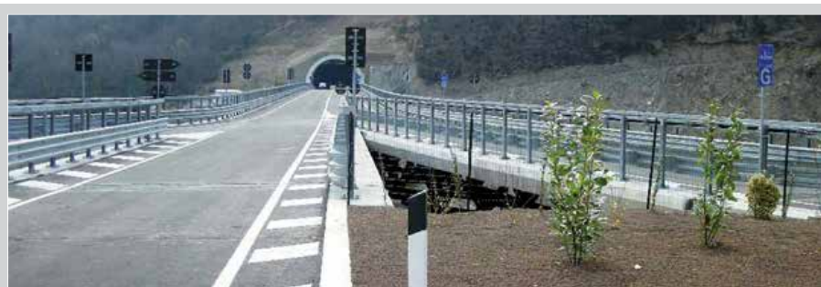
■ S.S. 28 "del Colle di Nava" - Galleria Pieve di Teco
