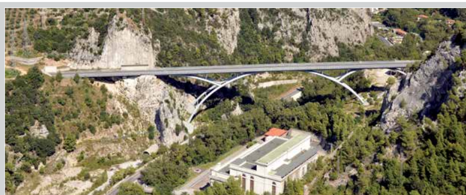
■ S.S. 79bis "Ternana" - Ponte delle Marmore
