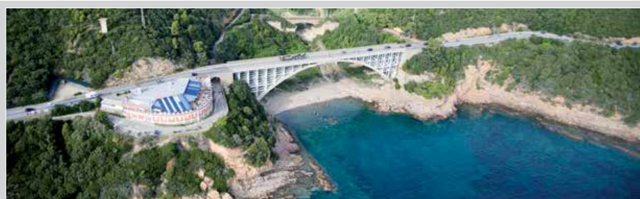
■ S.S. 1 "Aurelia" - Ponte di Calignai
