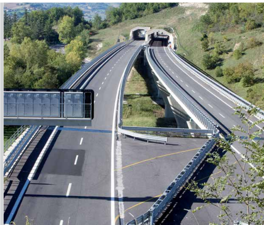
■ S.S. 77 "della Val di Chienti"- Viadotto Polverina
