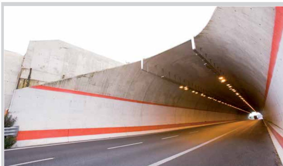
■ Autostrada A3 Salerno-Reggio Calabria - Galleria Seppia
