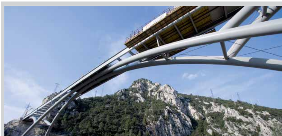
■ Direttrice Civitavecchia-Orte-Terni-Rieti - Ponte ad Arco sul Fiume Nera
