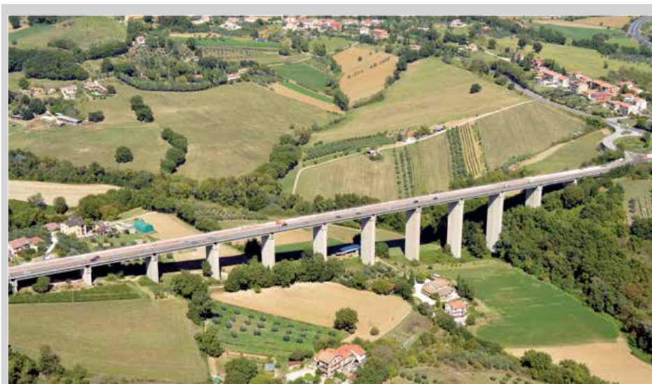
■ S.S. 675 "Umbro-Laziale" - Viadotto Fiacchignano
