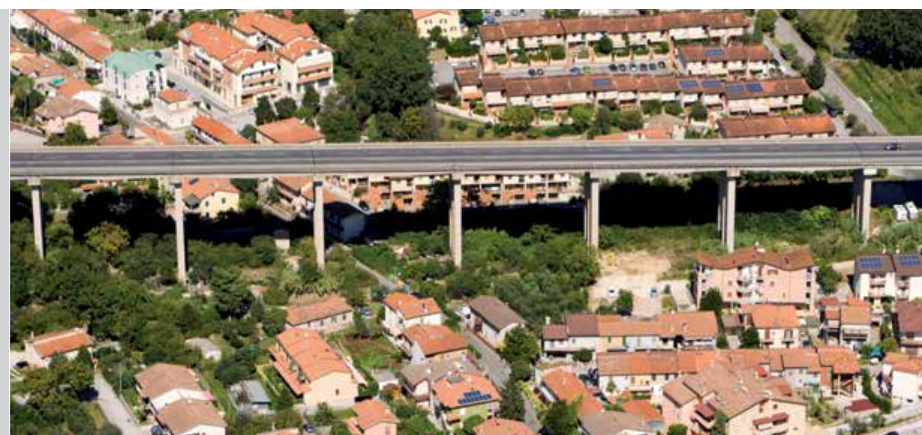
■ S.S. 675 "Orte-Terzi" - Viadotto Toano
