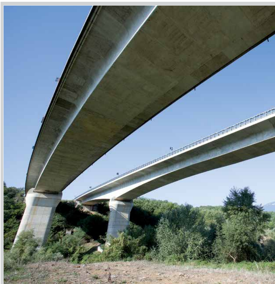
■ Autostrada A3 Salerno-Reggio Calabria - Ponte Tensa
