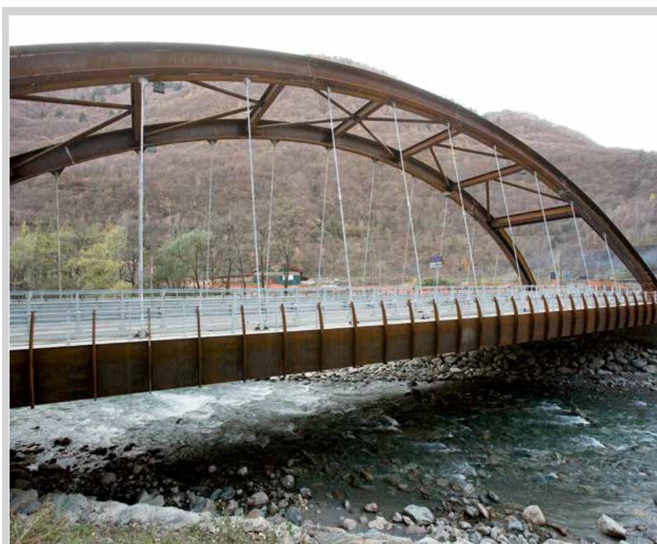
■ S.S. 42 "del Tonale e della Mendola" - Ponte Saletto
