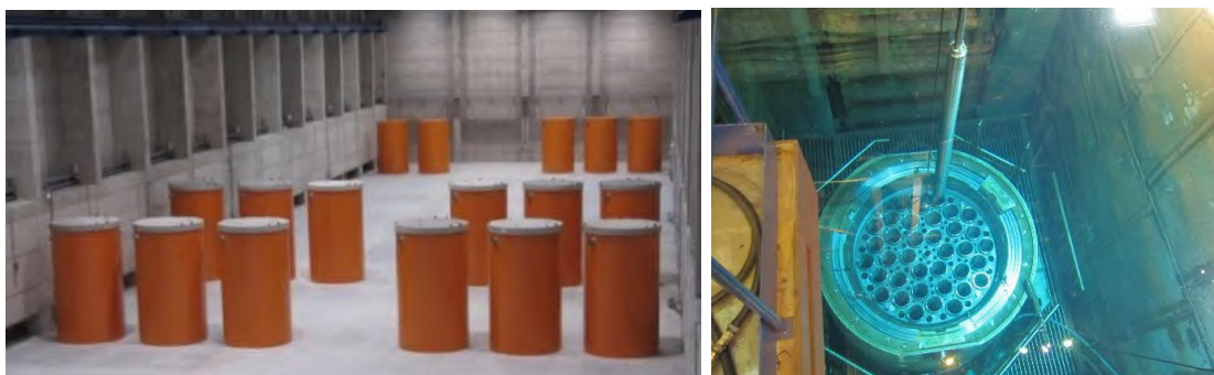
Figura 7: impianto di stoccaggio provvisorio con nuovi fusti per gli elementi di combustibile esaurito
